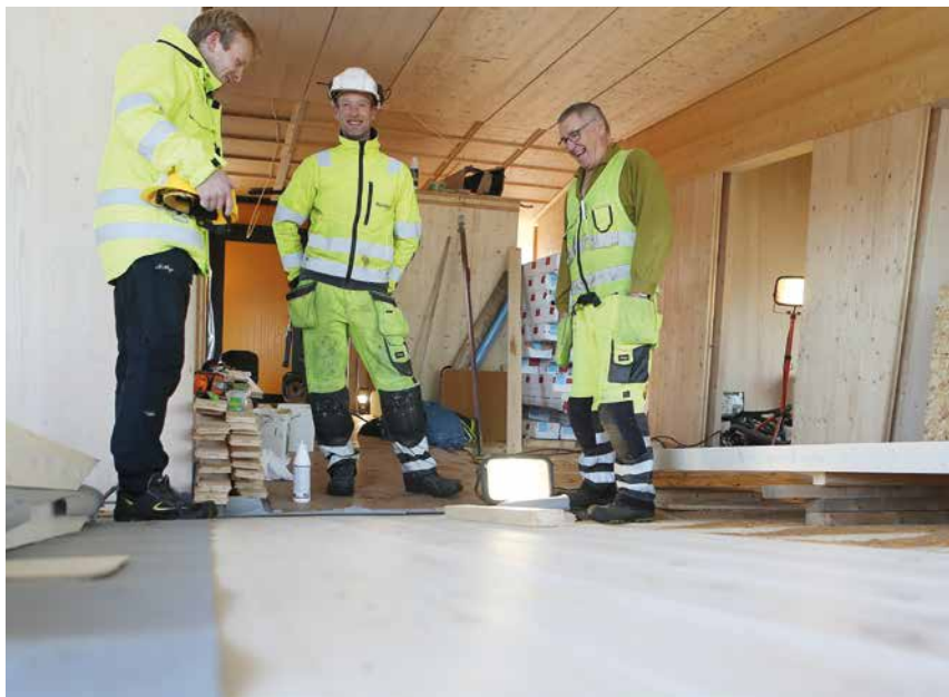
Prosjektleder Dragmyrhaug (t.v.) drøfter framdriften med bas Grytbakk og tømrer John Einar Skogås. Over massivtregulvet legges furugulv.
