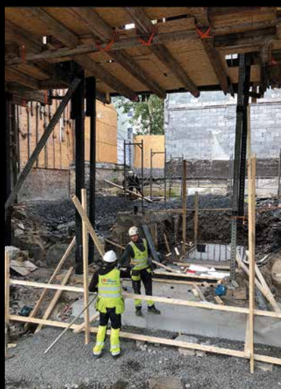
Nytt fundament er lagt opp på den gamle grunnmuren for å forsterke og gjøre den mer solid. (Foto: Byggmester Asle Thorsen)
