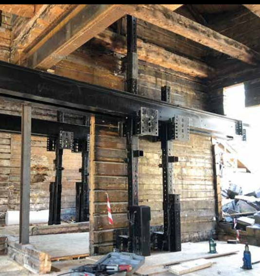
Jekket opp: - Med eksperter som Bjarne Lofthus som jekker opp nøyaktig på mange nok punkter, går slike tiltak bra, sier Thorsen. (Foto: Byggmester Asle Thorsen)
