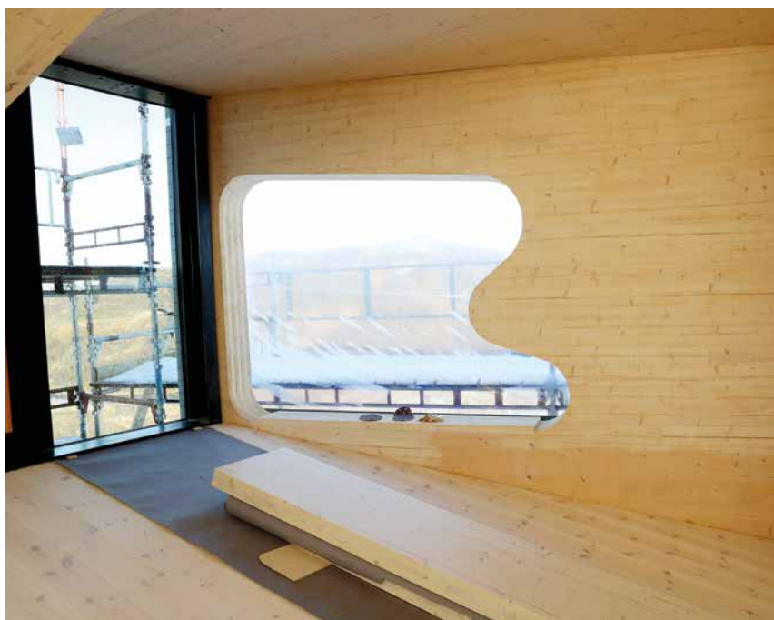
Elementet er skåret ut med vindusåpning. På utsida er det et tre lags panoramavindu som dekker store deler av vegg.
