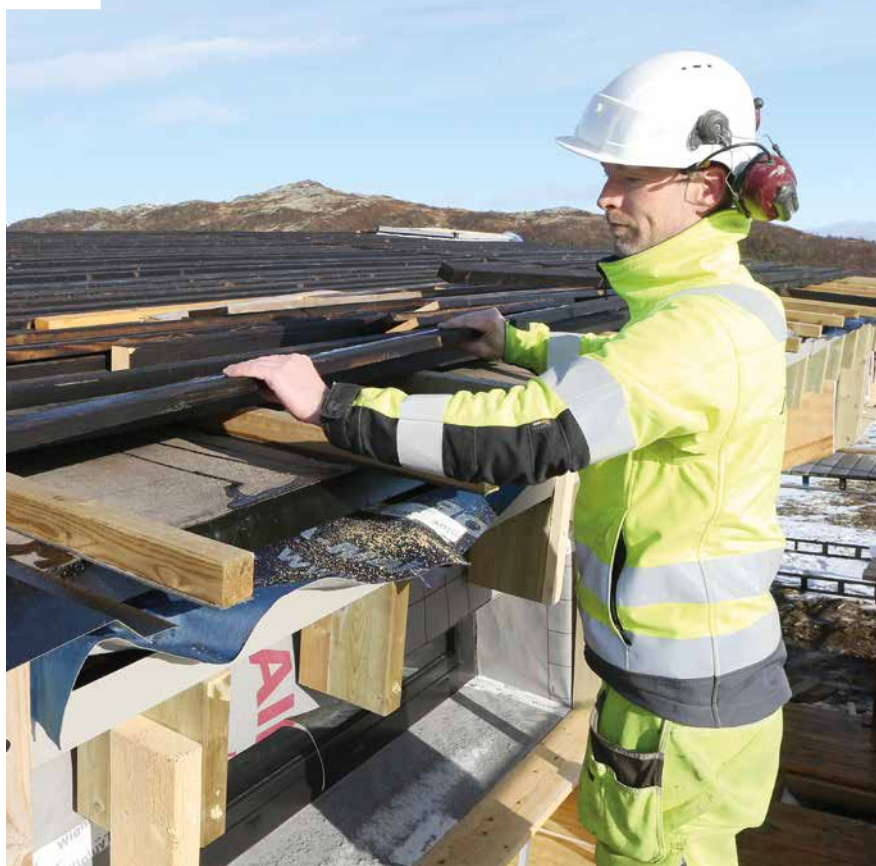
Grytbakk legger brent panelbord på taket.
