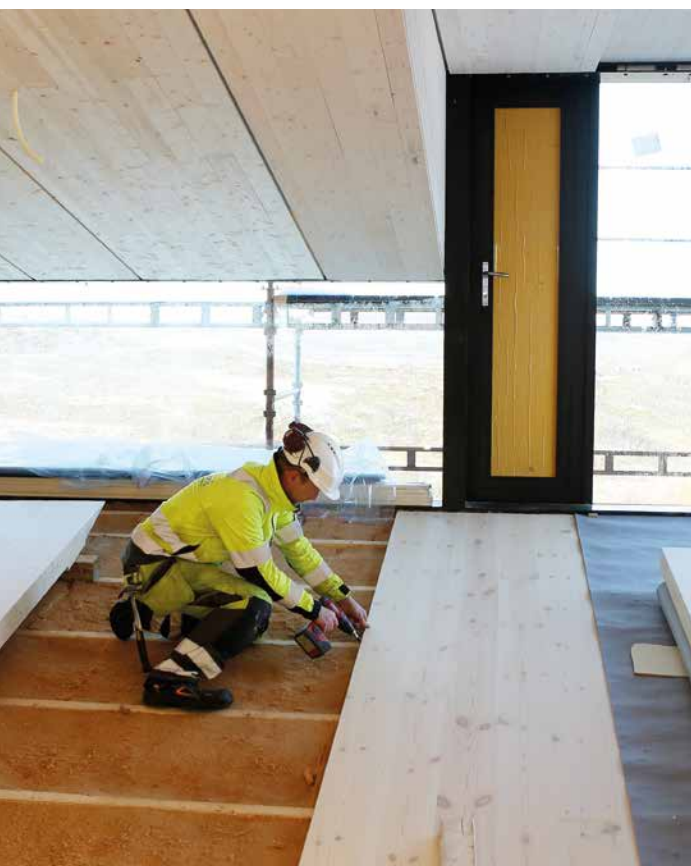
Gulvet skrår oppover og taket skrår nedover mot vinduet.
