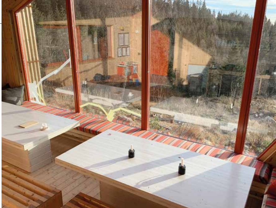
SPRAKK: Panoramavinduet på Turistforeningens Fuglemyrhytta sprakk fordi pynteputer mot ruta skapte stor temperaturforskjell i deler av glasset. (Foto: Thomas With, DNT)
