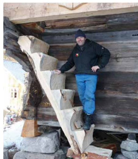
Ferdig med hugging av stokketrapp på loft i Setesdal.
