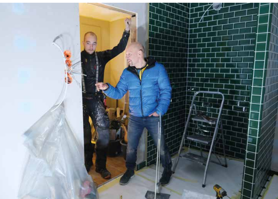
Byggmester Hansen og tømrer Adrian Moe diskuterer de siste detaljene ved en rehabilitering av et småhus i Tromsø sentrum.
