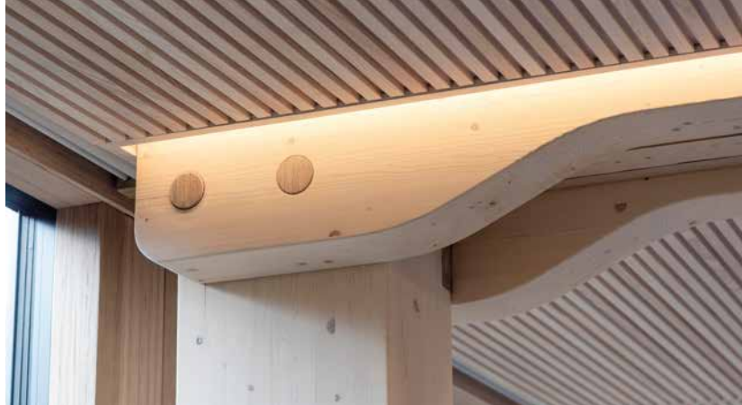
Slingingsmonnet var kun 0,1 mm for at dyblene av bok skulle passe inn i hullene i knutepunktene. (Foto: Sindre Ellingsen/Helen & Hard)
