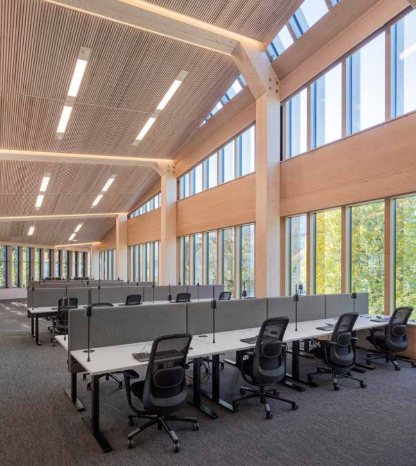
De ansatte får åpne og lyse kontorplasser. Siden bygget skråner, har det mange vinkler. Dyblene i slike skråvinkler måtte slås inn på stedet. (Foto: Sindre Ellingsen/Helen & Hard)
