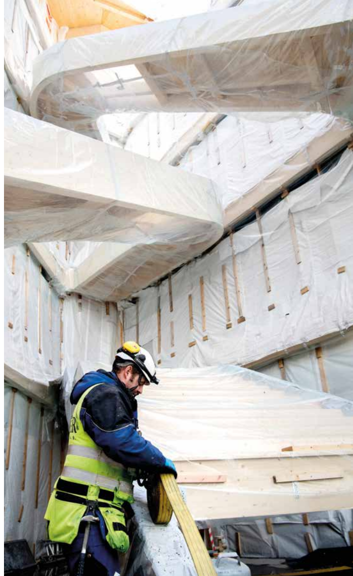
For å hindre vannskader, ble alle trekonstruksjoner dekket med plast til taket var på plass. Her jobber Raimi Pahapill fra Faber Bygg med trappene. (Foto: SpareBank 1 SR-Bank/Jan Inge Haga)
