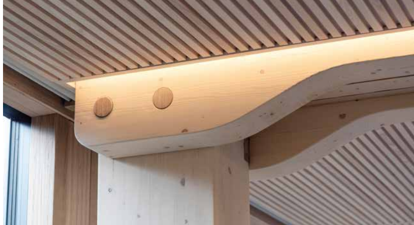
Slingringsmonnet var kun 0,1 mm for at dyblene av bøk skulle passe inn i hullene i knutepunktene. (Foto: Sindre Ellingsen/Helen & Hard)
