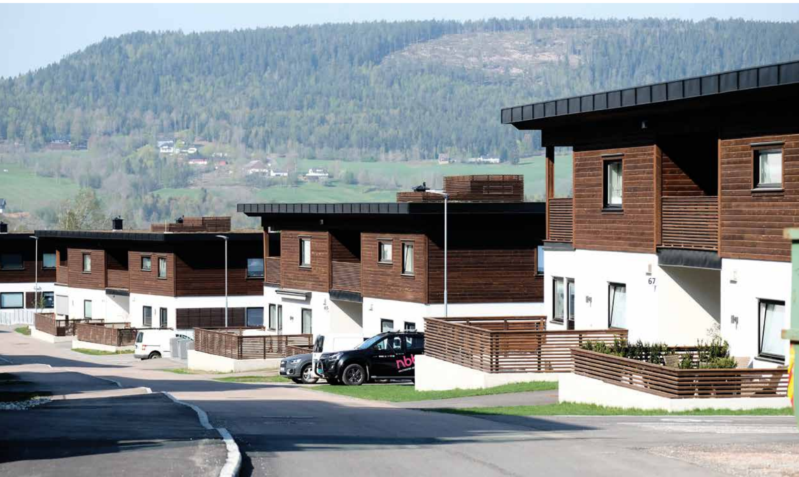
INGEN ANLEGGSSVEI: Villa Wiig har latt de ferdige blokkene få fred for anleggsmaskiner og brakker - egen anleggsvei er lagt nedenfor prosjektet.
