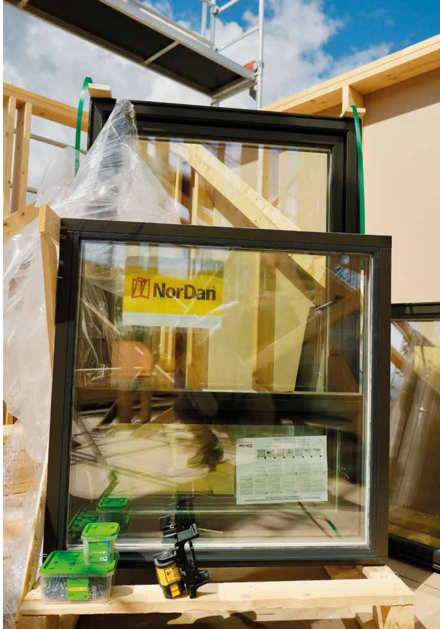
Follohus får vinduer til andre etasje løftet opp i huset med kran.
