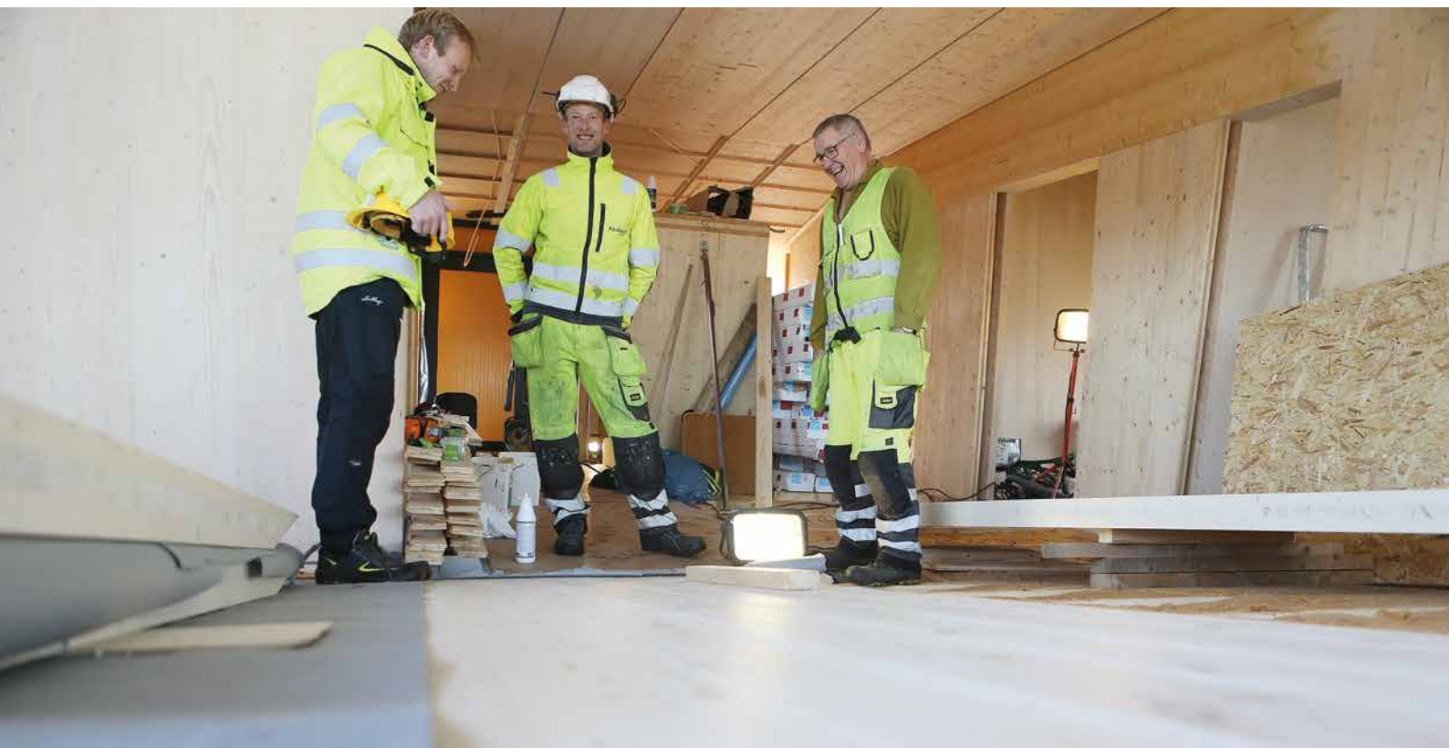
Prosjektleder Dragmyrhaug (t.v.) drøfter framdriften med bas Grytbakk og tømrer John Einar Skogås. Over massivtregulvet legges furugulv.
