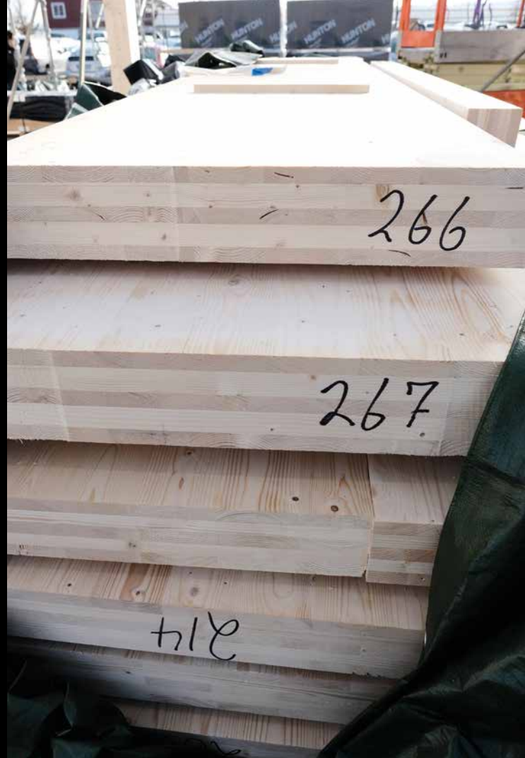
Elementene leveres i omganger til byggeplassen på Stokke. Her venter veggelementer på å bli heist opp.
