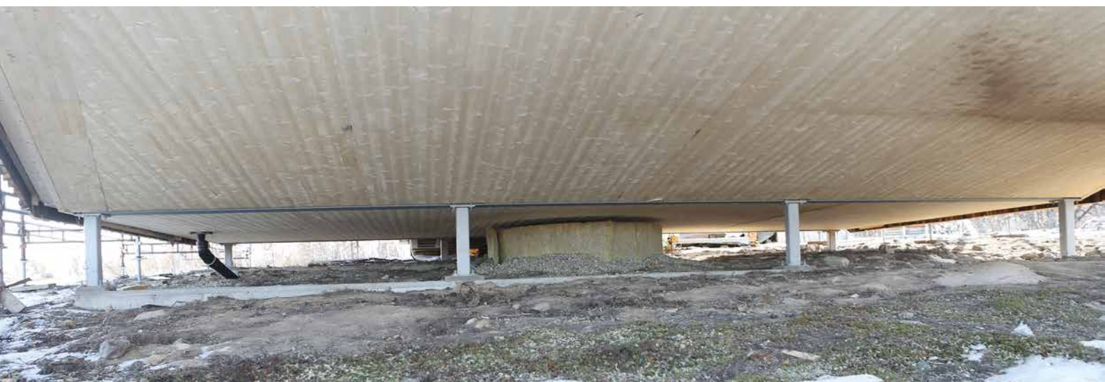
Fundamentet består av noen striper betong under stålsøyler for at hytta skal gi minst mulig skade på vegetasjonen.
