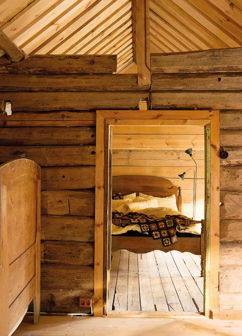
Opprinnelige laftestokker danner tre kvart vegg mellom gang og soverom. Det var Ingers idé. Gulvet i gangen er ny furuplank. (Foto: Eva Kylland)
