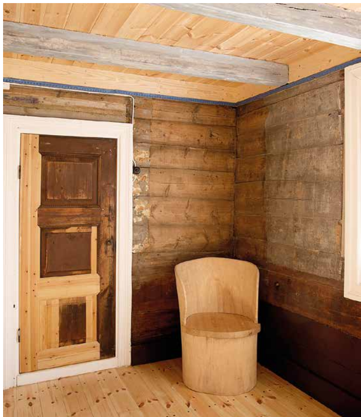
Den markspiste døra var bygd inn i stueveggen, André Rose ved Arendal Snekkerverksted har restaurert den. Listene rundt døra er gjenbruk av originale. (Foto: Eva Kylland)
