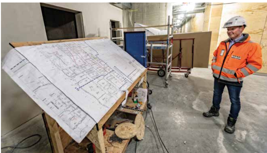
Prosjektleder Roy Gunnar Berg er klar på hvorfor massivtre er et godt valg for Alta omsorgssenter. – Fordi det er mange små rom, korte spenn i dekkene og ikke et bygg som skal endres etter hvert.
