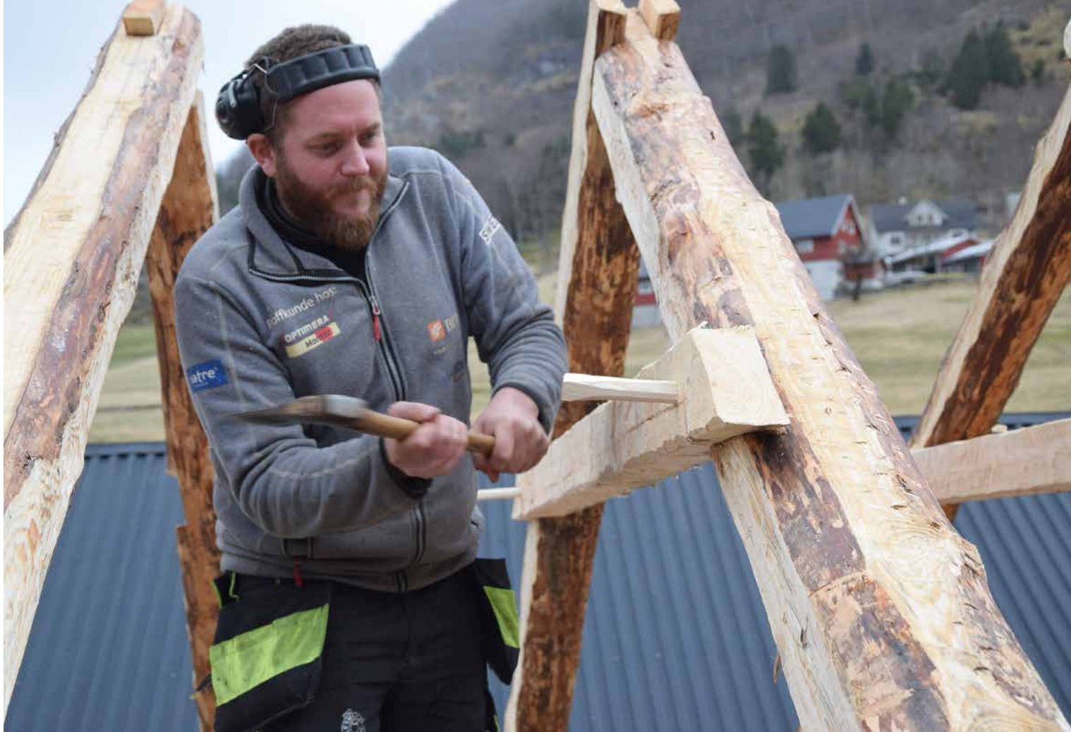
Ole Kristian Hatlen banker pluggen inn så hanebjelke og taksperre skal holdes sammen.
