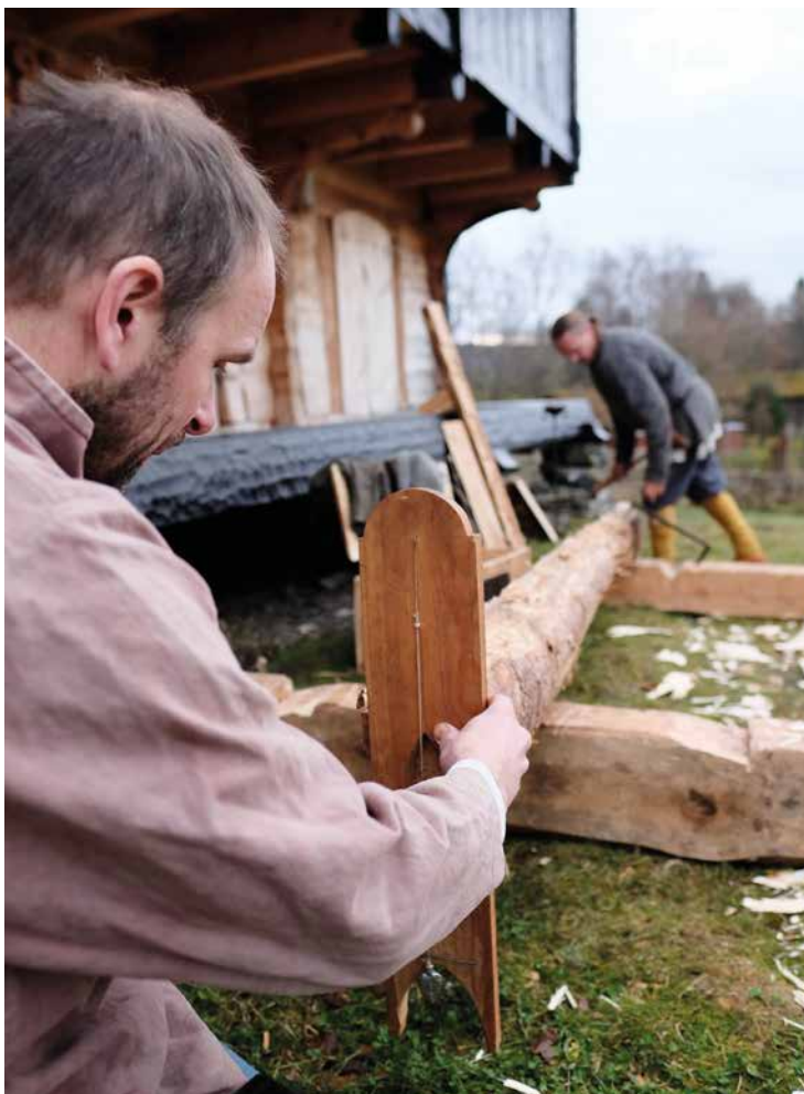
– Det er ikke vanskelig å bruke loddfjøl. Vi merker av med kniven og bruker sotsnor slik at vi får en rett linje langs stokken, forklarer Johansen.
