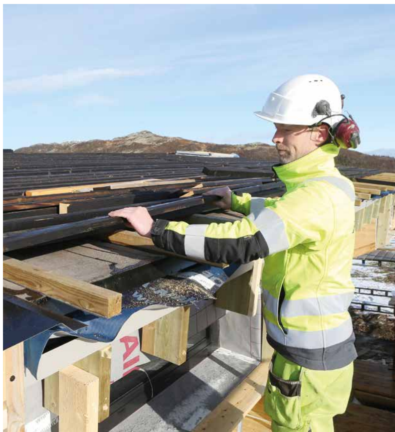
Grytbakk legger brent panelbord på taket.
