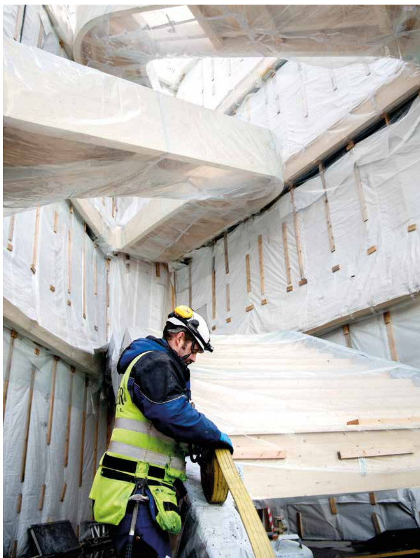
For å hindre vannskader, ble alle trekonstruksjoner dekket med plast til taket var på plass. Her jobber Raimi Pahapill fra Faber Bygg med trappene. (Foto: SpareBank 1 SR-Bank/Jan Inge Haga)
