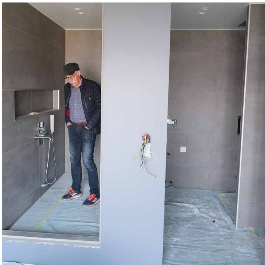
Alle badene plassbygges med rupanel på alle vegger før våtromsplatene legges på.
