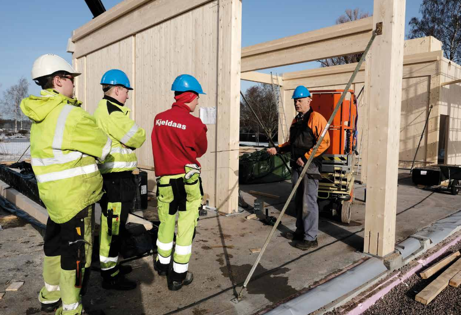
Byggfaglærer Johan Bue forklarer montasje av massivtrelementer for Vg1-elevene.
