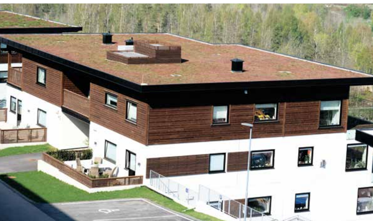
På takene er det lagt sedum for at beboerne i bakre rekke skal slippe de å se ned på åpne membraner og takpapp, dessuten er sedum miljøvennlig og drenerende.
