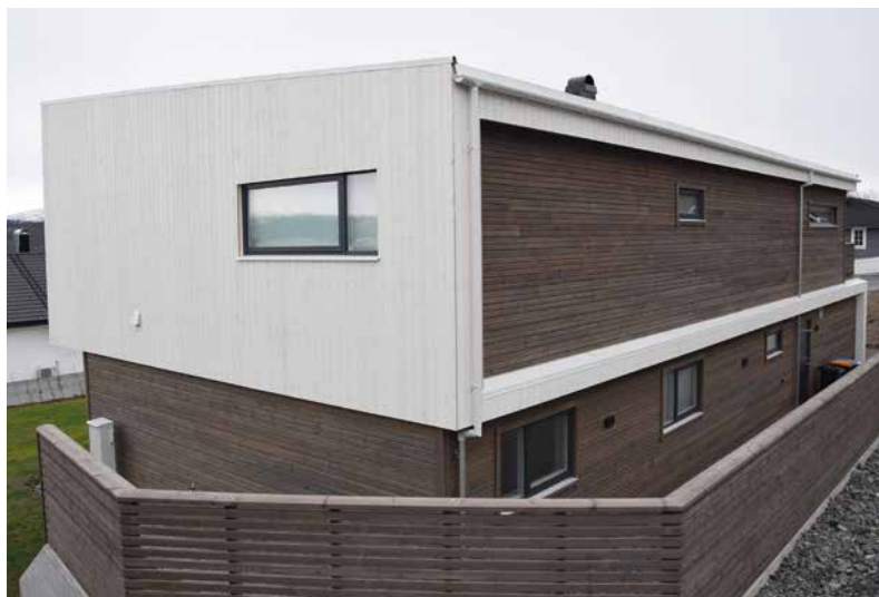
Boligene bygges med pulttak og takrenner og nedløp på den ene vegg. Stående og liggende kledning brukes for å variere uttrykket.
