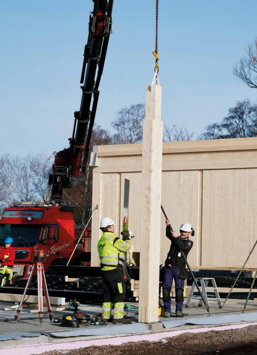
Elementene leveres i omganger til byggeplassen på Stokke. Her venter veggelementer på å bli heist opp.
