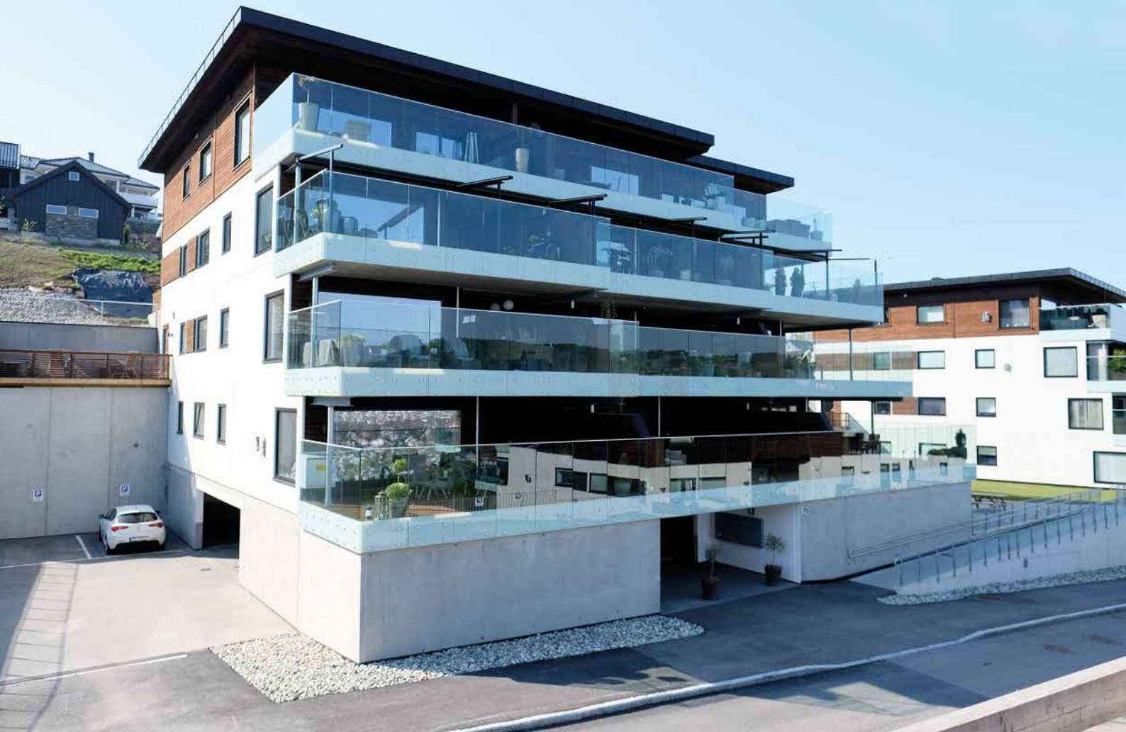
Det er gravd ut ytterligere fire etasjer, noe som tilsvarer 12 meter under terreng i bakkant på blokken.
