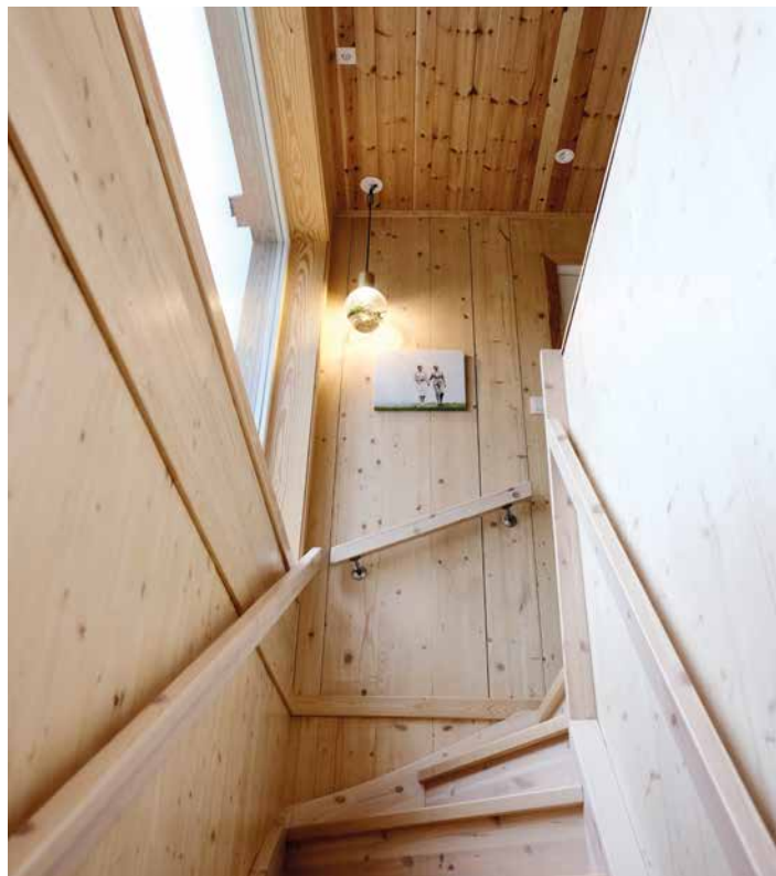
Innvendig er hele huset kledd med standard 200 bred trepanel fra Termowood.
