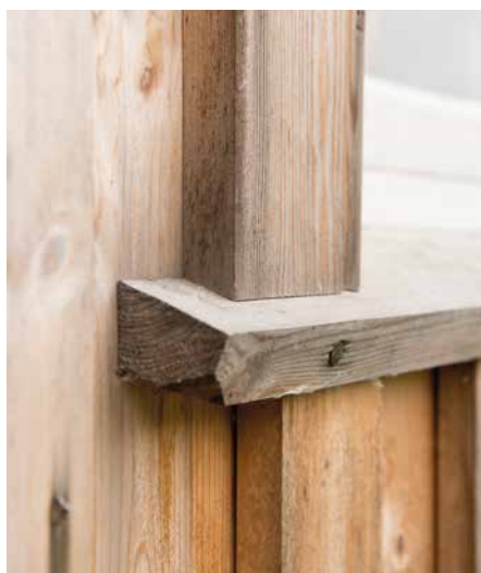
Treverk mot treverk, uten impregnering eller beslag, er en trygg løsning, som er utprøvd i mange hundre år.
