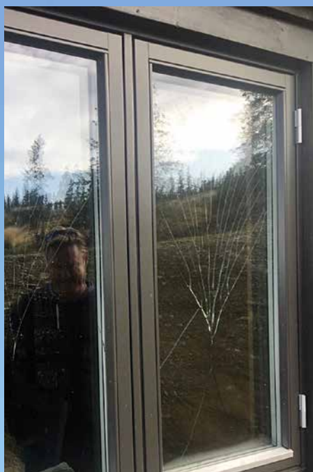
Trykkbruddet har oppstått ganske raskt etter at denne hytta ble oppført – andre ganger kan det ta lenger tid. (Foto: Tipser)
