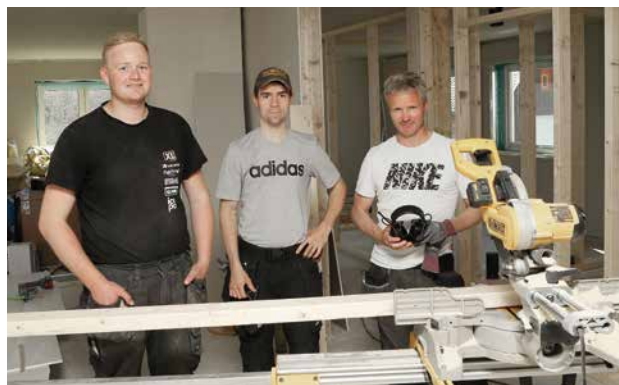
Tømrerbasene Jørgen Amtoft (t.v.) og Baard Roberth Stenbro (t.h.), sammen med tømrer Peder Talsnes holder på med det store huset på Byåsen.
