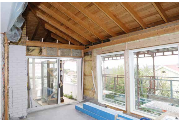
Bjelkelaget i himlingen var fem tommer. Taket heves og forsterkes med åtte tommer bjelker.
