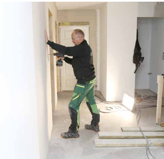
Tømrer Håvard Øvereng monterer gipsplater.
