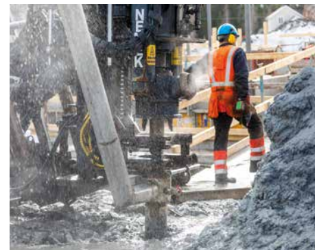
Brønnboring på prosjektet. (Foto: Binde Gruppen)
