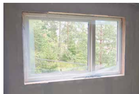
Tømrrerne i Håndverksbygg har montert veggelementene og tilpasset kledningen utvendig. Selve montasjen av vinduet er gjort på Konsmos elementfabrikk.
