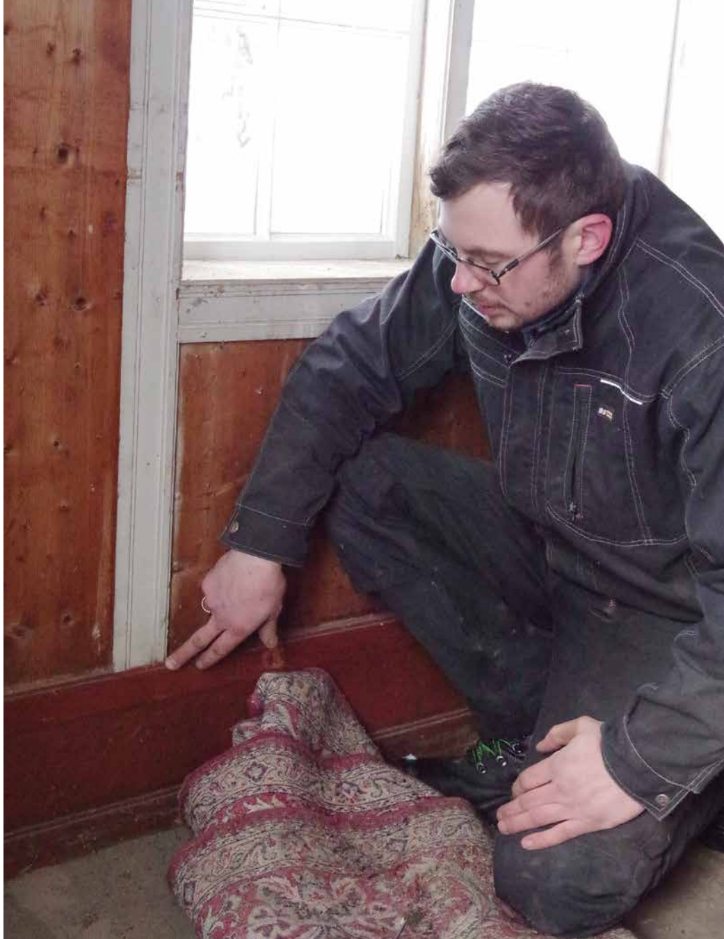
SLIK TENKTE DE PÅ TETTING: Karm og foring er ett stykke, og er sammenføyd til panel med not og spor. De to sidelistene har taper ned i fotlista, forklarer Lien.
