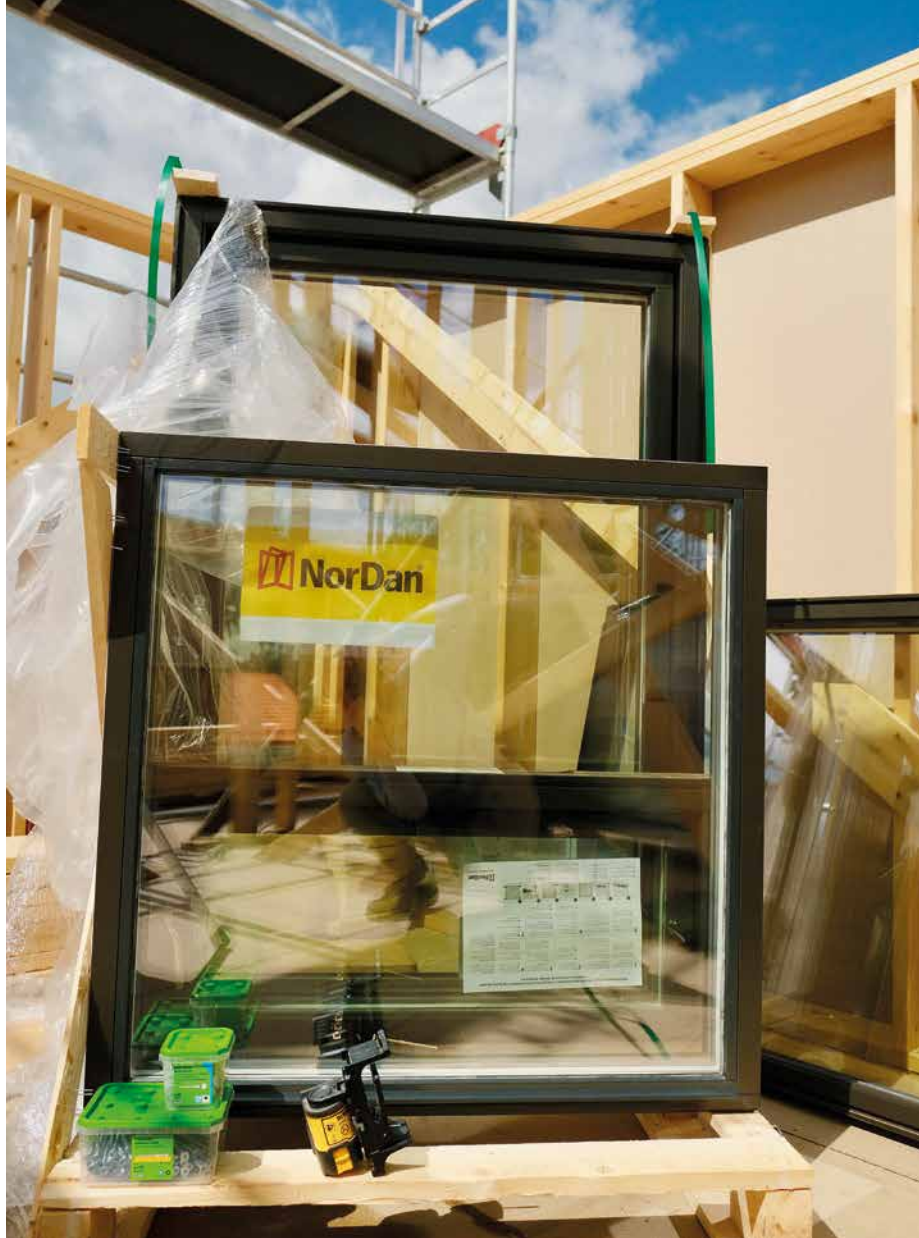
Follohus får vinduer til andre etasje løftet opp i huset med kran.
