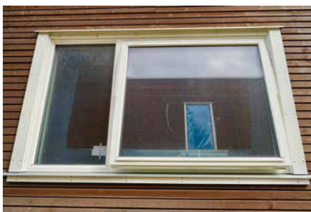
Trevinduene fra Uldal er tettset rundt med dyttestrimmel og fuget på utsiden. Nå er det tett.
