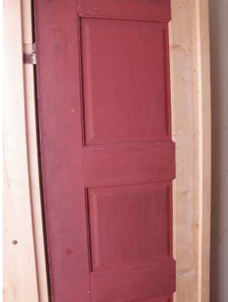
Nå er skader i den gamle inngangsdøra utbedret.
