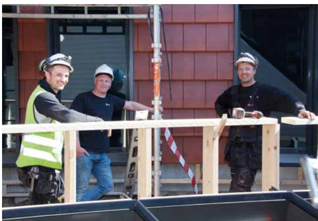
Tom Gerhard Strand (t.v.), Espen Johansen og Kjetil Sedberg setter opp vegg foran terrassen til nybygget.
