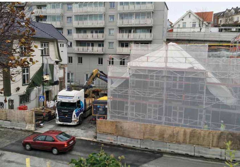
Kongsgata 54 ble revet og tomta brukt til vareleveranse før huset ble bygget opp på ny. (Foto: DEVO)
