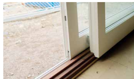
Fire mann og løfting med sugekopper måtte til for å få skyvedørene på plass.
