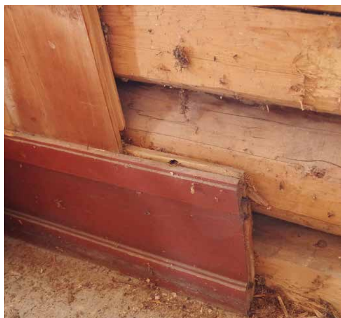
Den breie sokkellista har spor for å sette panelborda ned i.
