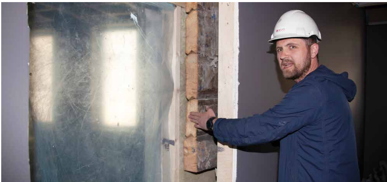
Der Kongsgata 58 og 60 bygges sammen kommer den gamle kledningen til syne. Det er for at man i ettertid kan spore tilbake til de ulike byggeepokene. – Det er stilig, men utfordrende for oss, sier Kristoffer Pittman.
