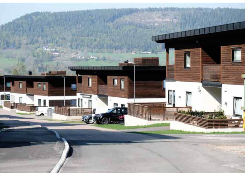
INGEN ANLEGGSSVEI: Villa Wiig har latt de ferdige blokkene få fred for anleggsmaskiner og brakker – egen anleggsvei er lagt nedenfor prosjektet.
