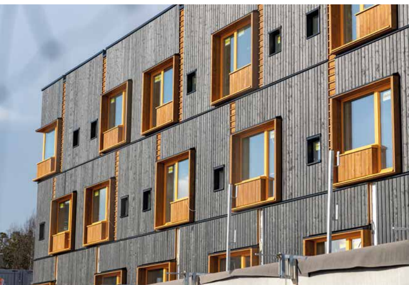
Nå begynner fasadene på ett av byggene å bli ferdige.
