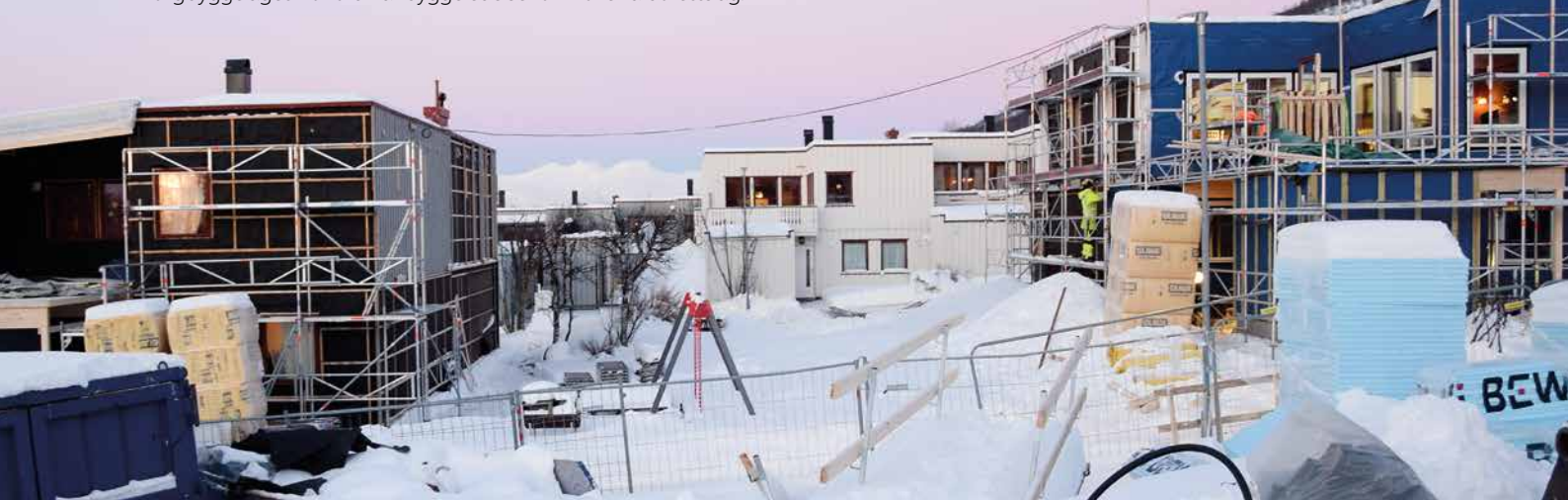
Rehabiliteringen i tre stadier: Ribbet vegg inn til gammel vindspærre, ikke påbegynt og med ny vindspærre, og ny kledning på vei oppover en vegg.
