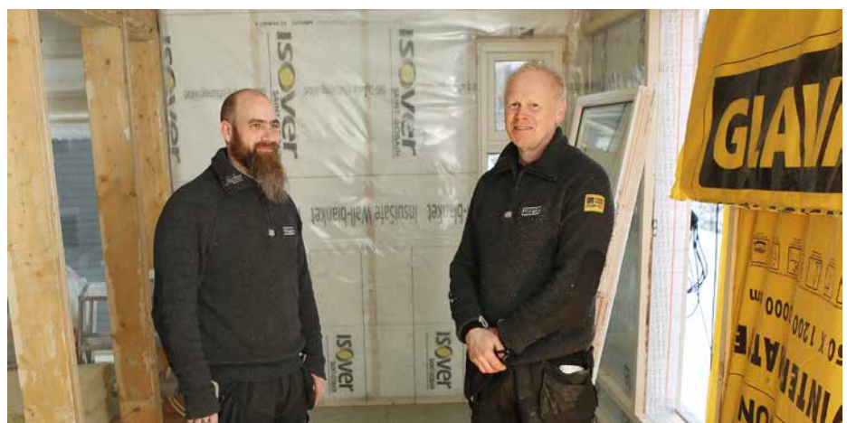
Bas Rune Tørnte og tømrer Roar Bankerød Nilsen i Vingrom Bygg AS synes det greit at de slipper å drive med isolasjonsmatter. Her i et tilbygg til en enebolig ved Lillehammer.
