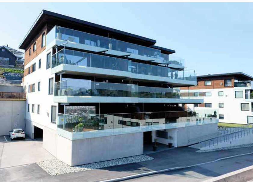
Det er gravd ut ytterligere fire etasjer, noe som tilsvarer 12 meter under terreng i bakkant på blokken.
