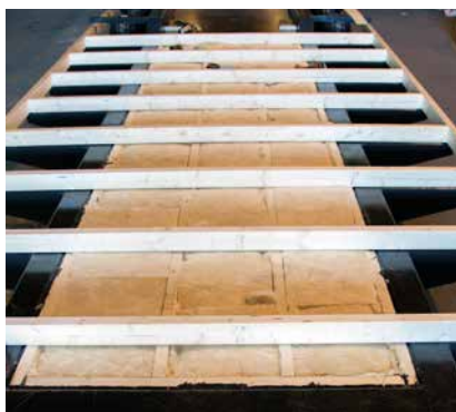
Etter at kamrene i tilhengeren er fylt med isolasjon, kunne husets gulvramme monteres. (Foto: Mari Louise Vik)
