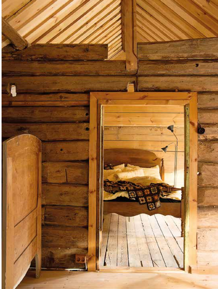
Opprinnelige laftestokker danner tre kvart vegg mellom gang og soverom. Det var Ingers idé. Gulvet i gangen er ny furuplank. (Foto: Eva Kylland)
