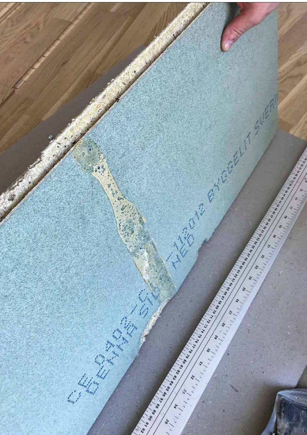
Da sponplatene ble tatt opp, viste limrestene seg som helt harde og krystallisert. Total-Bygg mener det er tegn på at limet ikke heftet som det skulle. (Foto: Total-Bygg Hjørungavåg AS)
