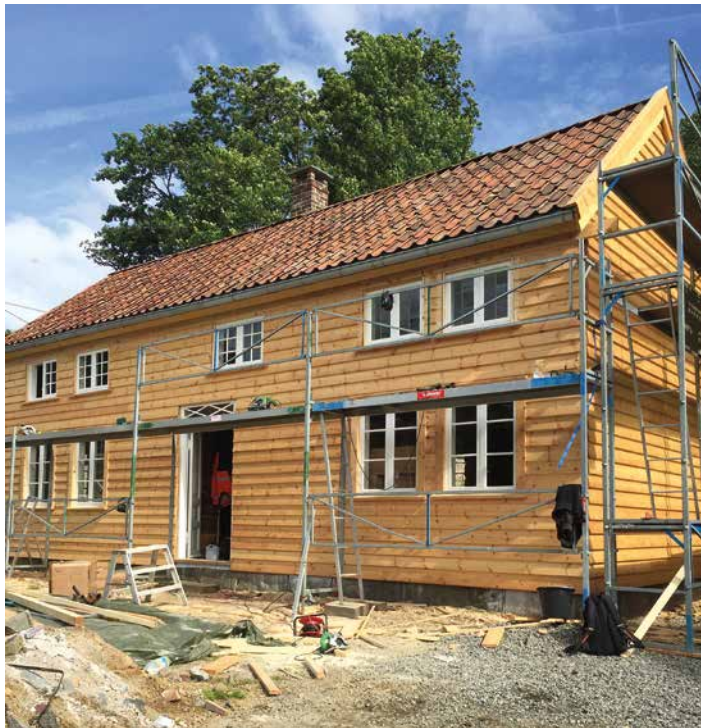
Kledningen mot vest er ferdig. (Foto: Privat)
