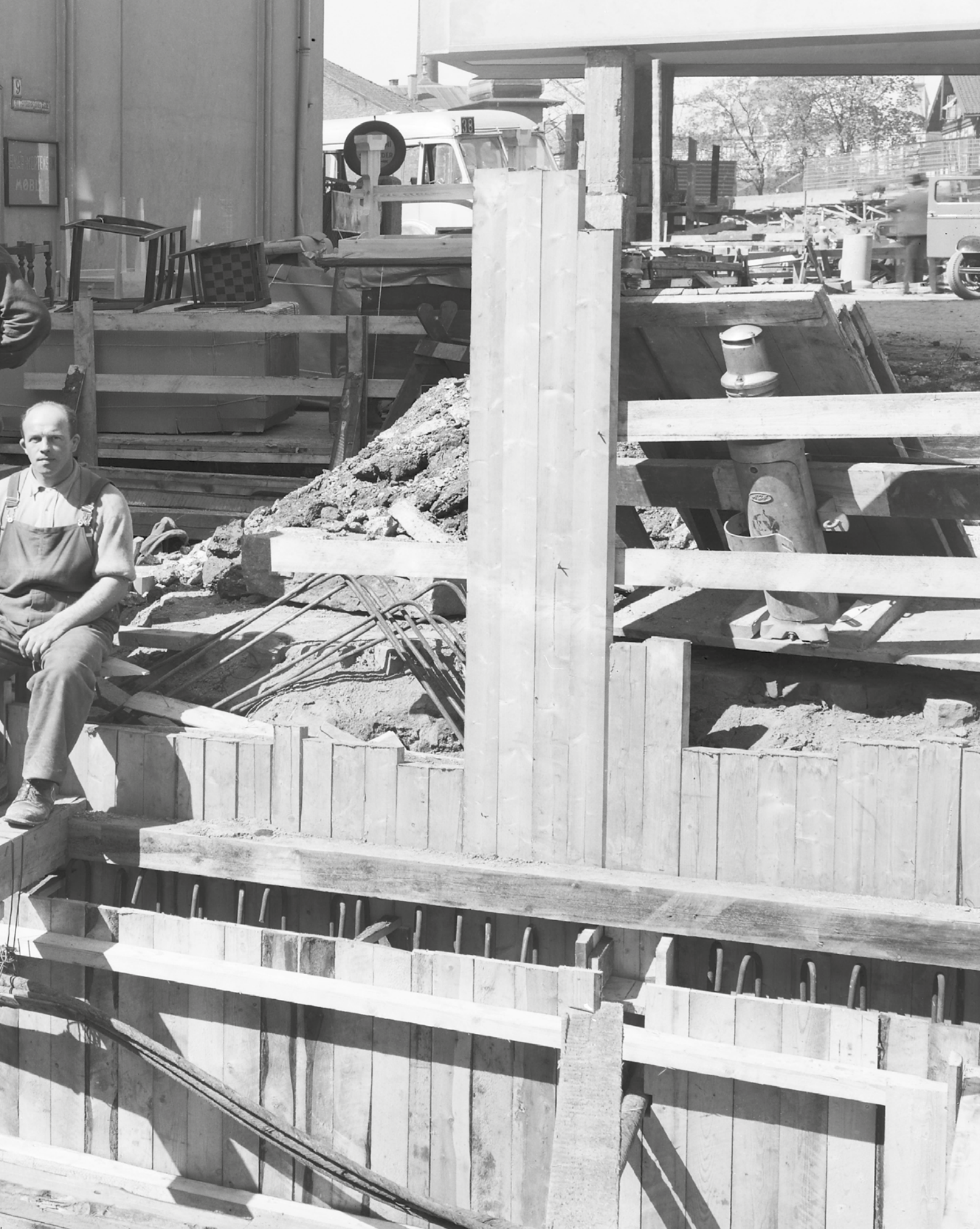
Et arbeidslag fra Oslo tar seg en velfortjent pause under byggingen av Fridtjof Nansens plass 7. Året er 1949.
