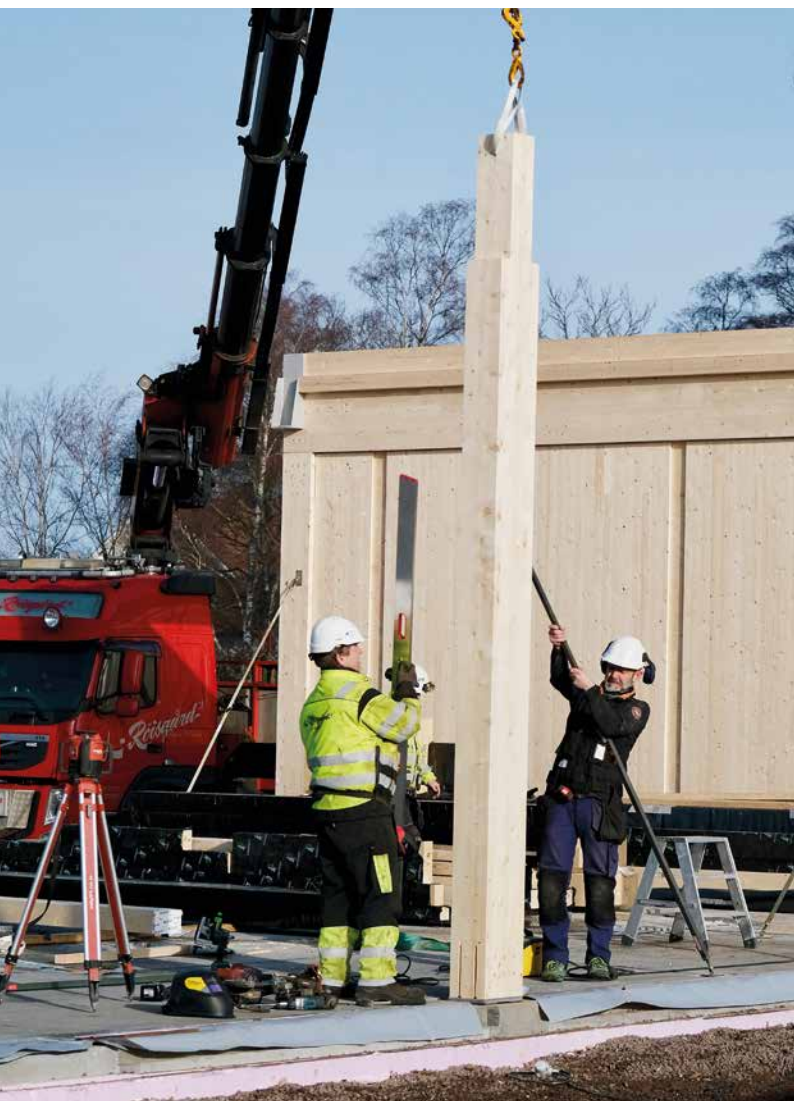
Byggfaglærer Johan Bue forklarer montasje av massivtreelementer for Vg1-elevene.
