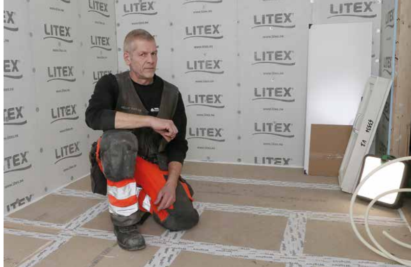
– Her skal det bli bad, forteller byggeleder Bjørn Jensvold. Her har de felt gulvplatene ned i bjelkene for å få bedre høyde i rommet.
