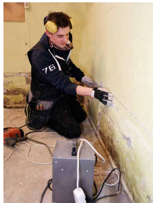
David Engelhardt-Olsen legger ledninger mellom elektrodehullene.
