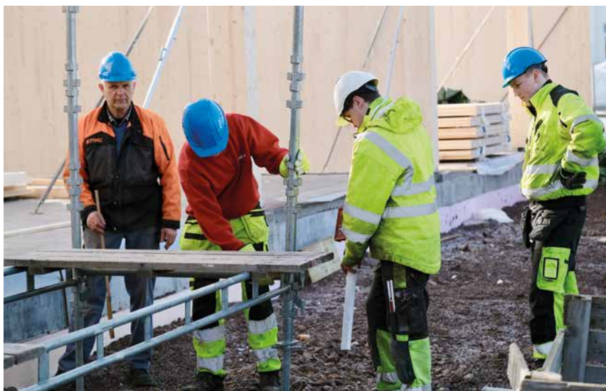
Elevene lærer å bygge stillasene som de selv skal arbeide i.
