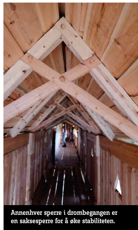
Bordene i sutaket på drombegangen er medratt til hverandre, og er skjøtet med en skrå skjæring for å få et tett tak. Mønnekjølen er hogd av et åtte meter langt emne. Alt er inspirert av bevarte tak på middelalderke kirkebygg.
