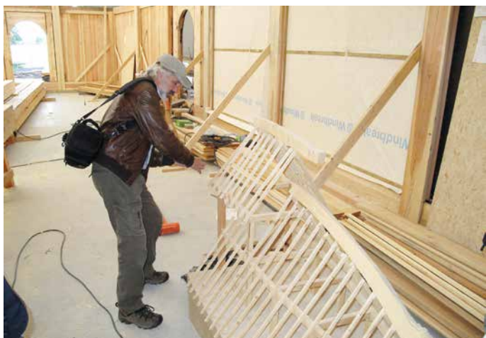
Ikke så lite stolt, viste Anders utdanningsutvalget Gildehallen i Borre i Vestfold september 2012. Timber AS hadde satt den opp, og en forklaring om takkonstruksjonene, hørte med.
