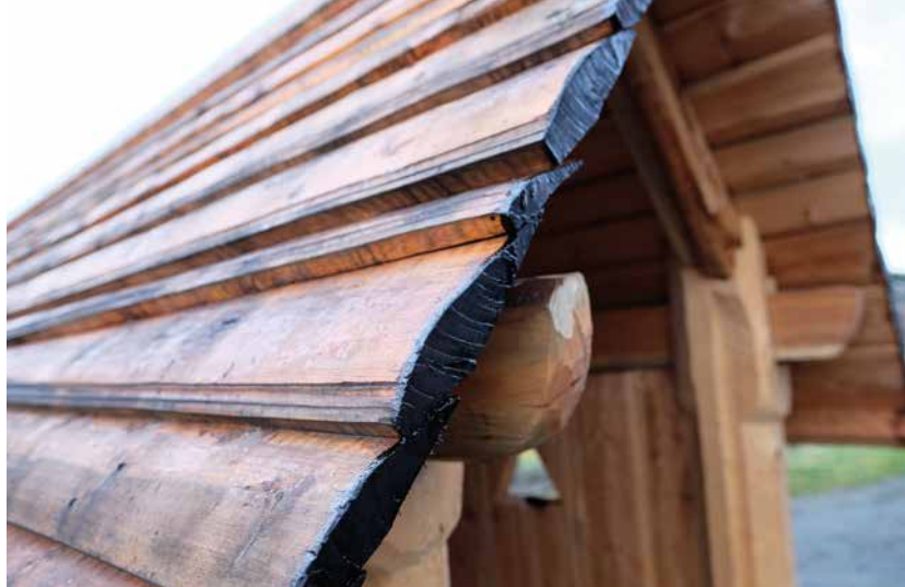
Bordene i sutaket på drombegangen er medratt til hverandre, og er skjøtet med en skrå skjæring for å få et tett tak. Mønnekjølen er hogd av et åtte meter langt emne. Alt er inspirert av bevarte tak på middelalderke kirkebygg.
