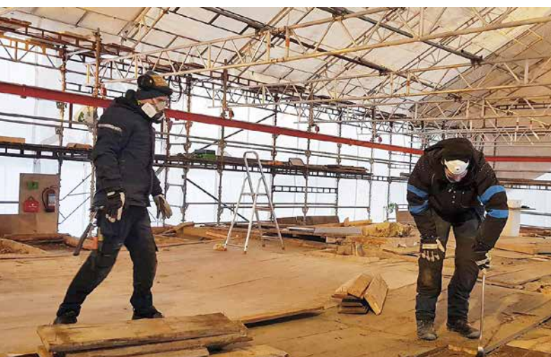
Under det store teltet kan rivingen og gjenoppbygging foregå uten fare for vær og vind. (Foto: Frøne)
