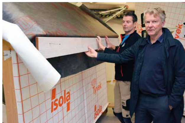
– Når første bane av undertaket er montert, skal den brettes rundt raftet og festes til toppsvill, forklarer Børmark og Larsen.
