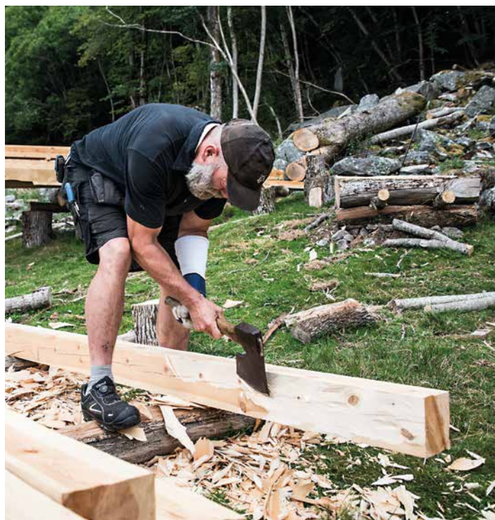
Bjelkene hogges til på gammelt vis.
