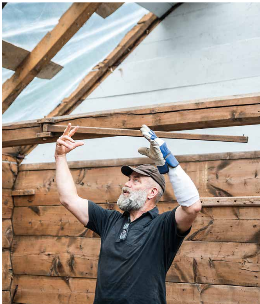
I ett av husene skal taket legges om, forklarer Tore Forsberg.
