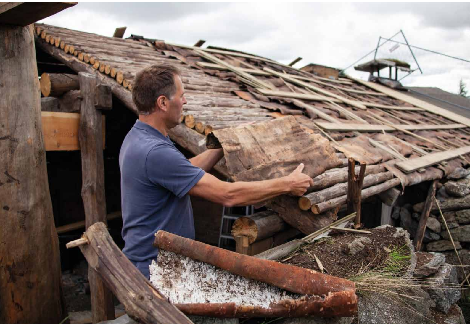
Harald Ueland viser hvordan neveren skal dekke stauren på taket. Noe never gjenbrukes fra det opprinnelige bygget.
