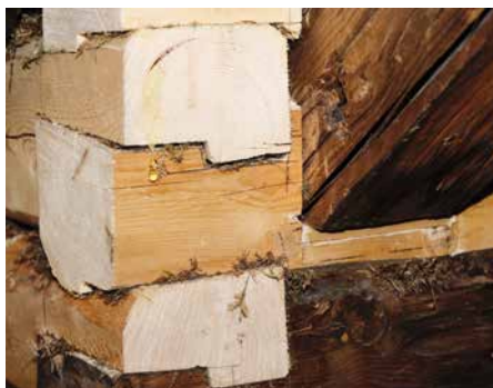
Nytt tømmer og råstoff til snekkerverkstedet er fra korteste leverandører – godt tett med husmose.
