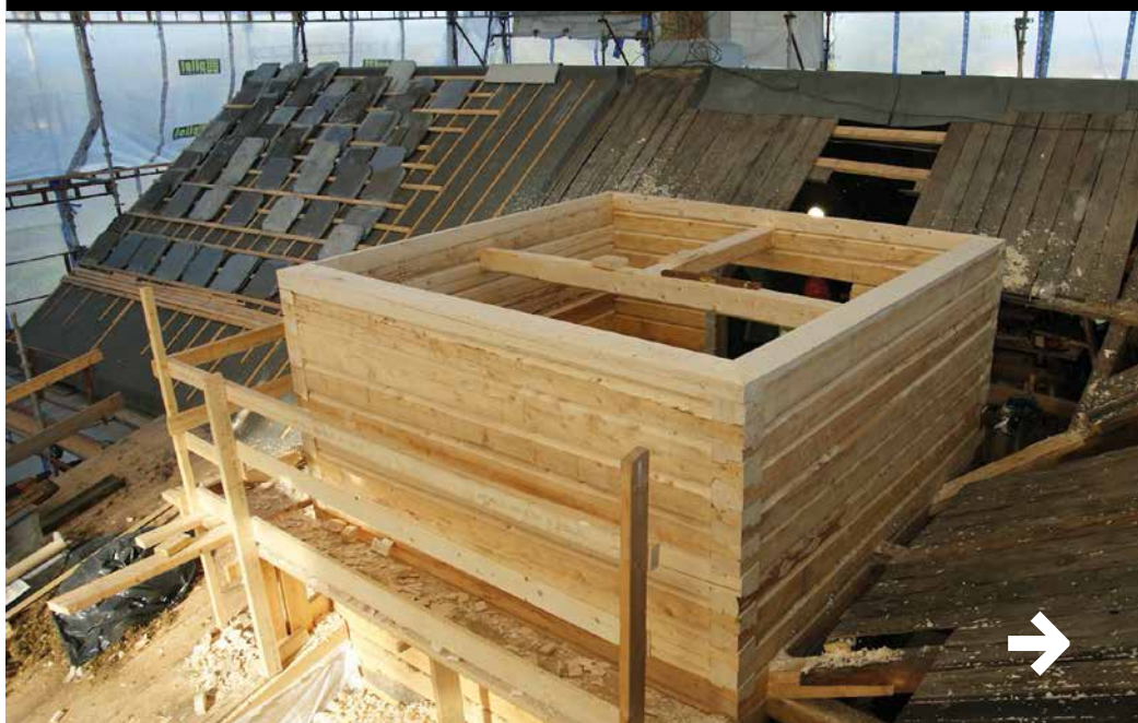
Nytt fundament til pjoftertårnet.
