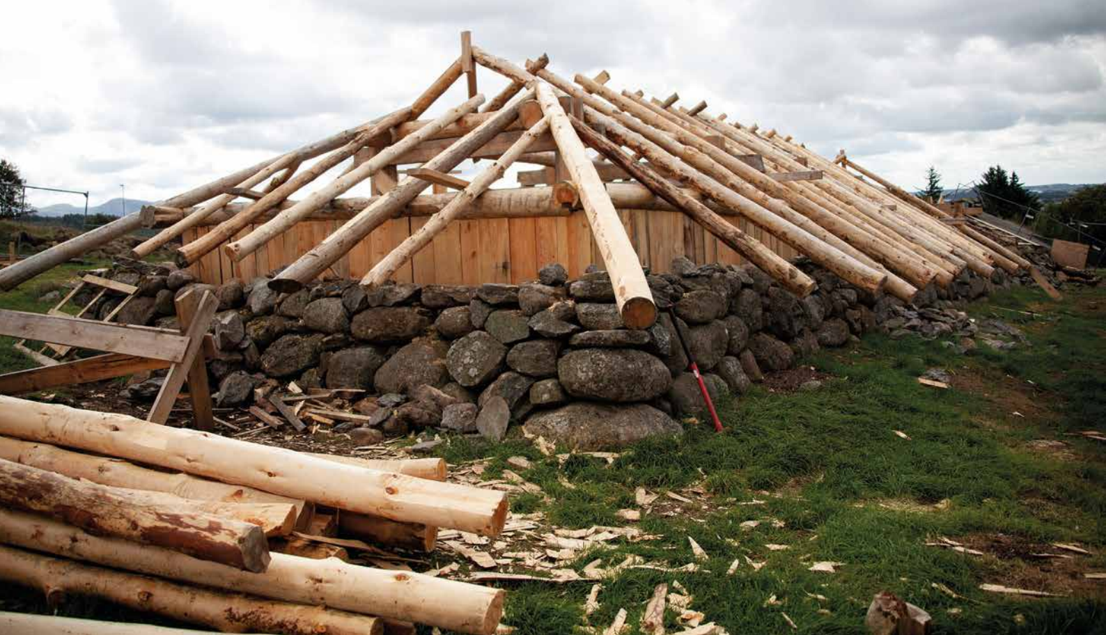
Den beskyttende steinmuren har grunnsteiner fra den arkeologiske utgravinga. Sperretaket er del av grindverkskonstruksjonen.
