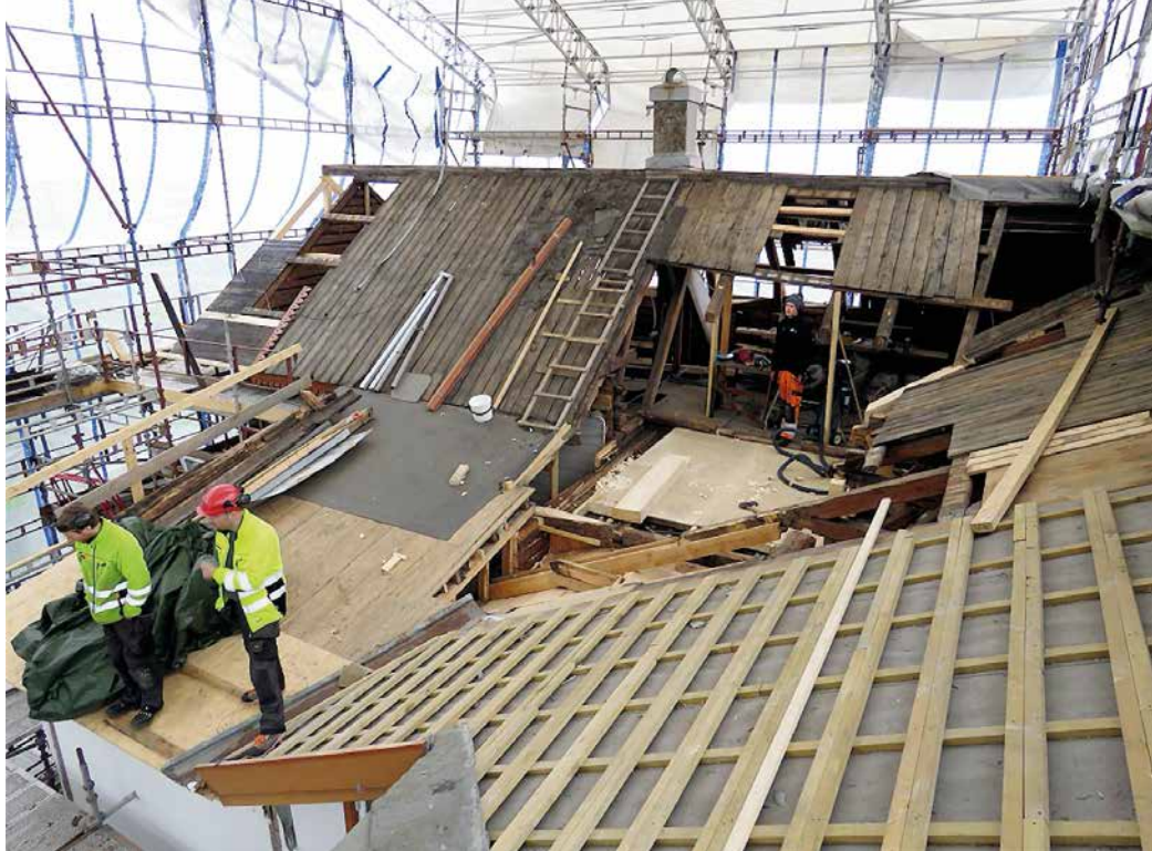
Utbedring av tak under tak over tak. (Alle arbeidsfoto: Braa & Sørvalg Bygg AS)
