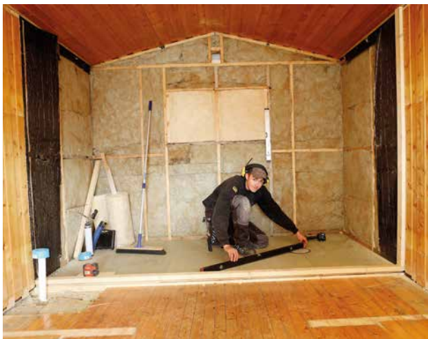
Martin Kristiansen i det som skal bli baderom i den nye hytta. Den gamle panelen på veggene og i taket skal kles med hvitmalte plater.
