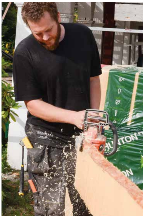
Ole-Kristian Hatlen høvlar eit av dei breie borda til sutaket.
