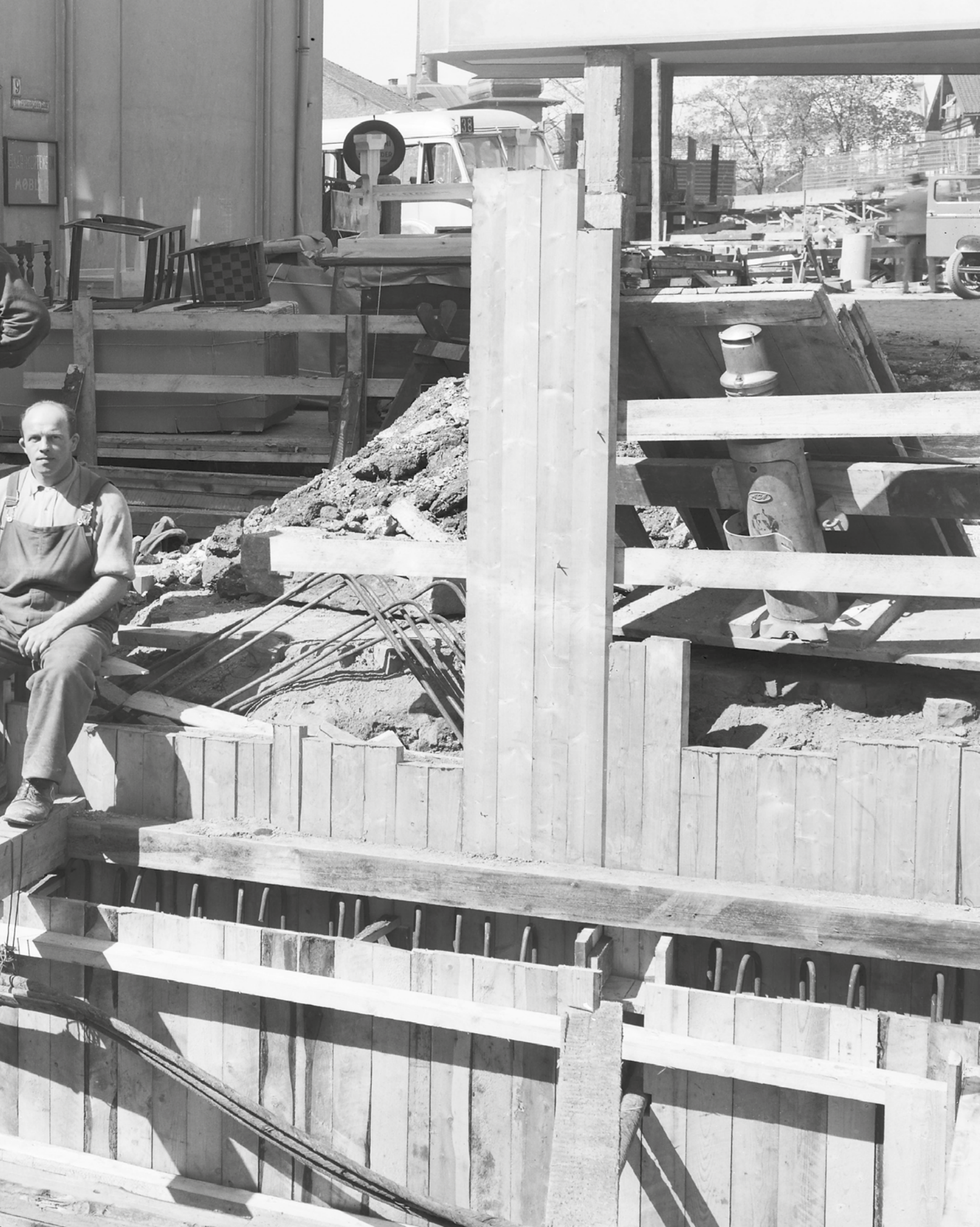
Et arbeidslag fra Oslo tar seg en velfortjent pause under byggingen av Fridtjof Nansens plass 7. Året er 1949.
