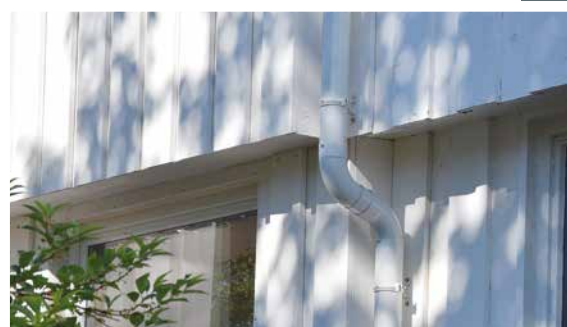
Taknedløpet er lagt i overgangen mellom oppgradert og opprinnelig leilighet. Dermed blir ikke 150 mm økt isolasjonstykkelse så iøynefallende.
