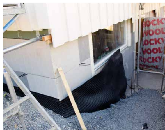
Grunnmuren er gravd opp, drenert og etterisolert med 100 mm ute og 50 mm inne.
