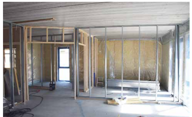
Trestendere brukes først og fremst i kjøkken og bad der det er behov for flere spikerslag, mens det ellers går i stålstendere.
