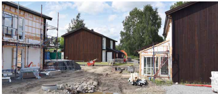
I boligfeltet Hestenga på Furnes har Heggelund Bygg satt opp sju tomannsboliger. Enda en skal opp før det er ferdig bygd.
