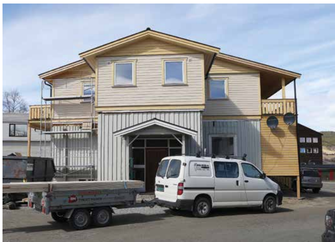
Hagengården på Tynset var gammel og nedslitt. Jess-Bygg sørger for at den blir som ny.
