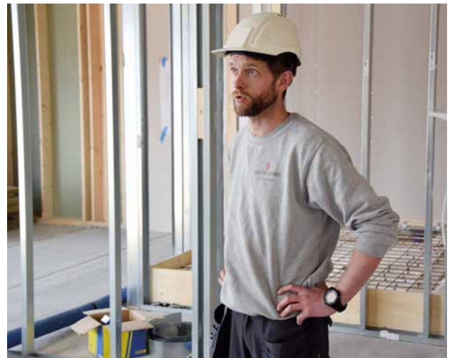
Byggeplassleder Kristian Moe synes prosjektet går bra selv om det er mange flere håndverkere i arbeid her enn på byggeplassene han pleier å lede.
