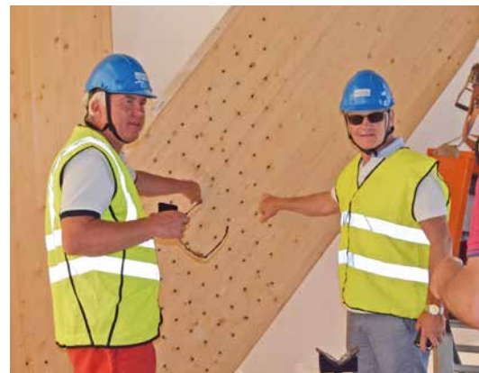
Per Ove Sivertsen og Bjørn Rune Markhus sjekker 100 dybler som holder sammen de enorme søylene.
