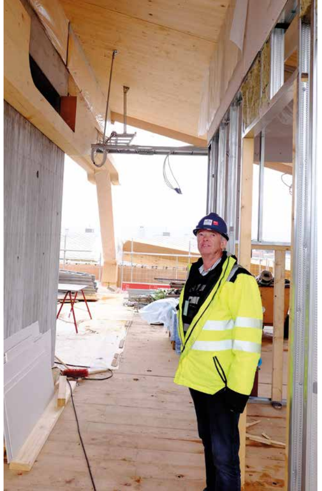
- Dette er et unikt prosjekt så vi må regne med unike oppgaver og løsninger underveis. Ingen har erfaring fra lignende bygg før, sier byggeleder Oddmund Torjussen i Faber Bygg.
