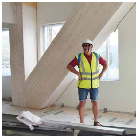
Rolf Eilerås blir liten ved siden av de kraftigste søylene på 1,50 x 0,60 m.
