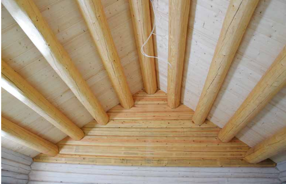
Vel ni meter lange åser av gran måtte hentes fra et sagbruk i de svenske finnskoger.
