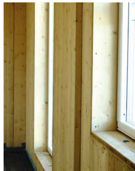
Veggelementene leveres tilpasset de store vinduene.
