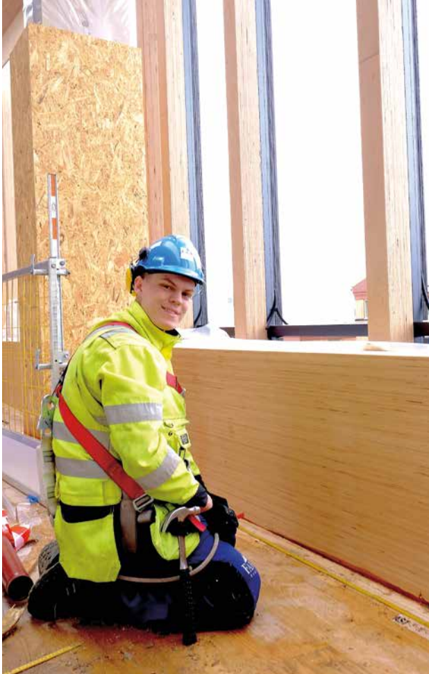
- Merke opp, bore og skru er mye av det jeg gjør på dette bygget, sier tømmer Kevin Rasmussen i Faber Bygg. Han synes det er kjekt å jobbe på Stavangers nye landemerke.
