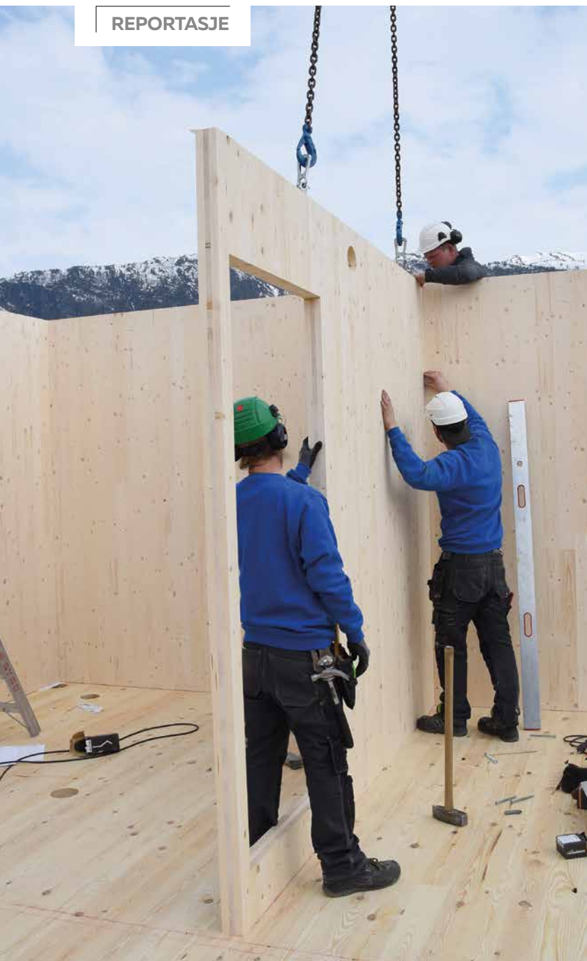
En vanlig 18V skrudrill brukes til å feste elementene.
