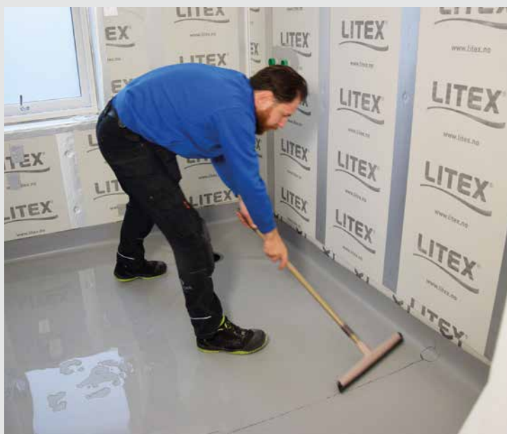
Gulvet svabres for å få vekk det siste vannet.
