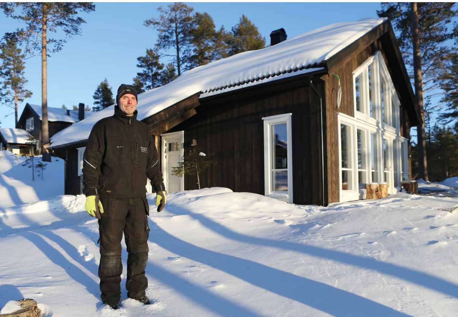
Per Ivar Tørset foran en av hyttene de har bygd i «Tørset Hyttegend» i Ulsberg. Her er det store vindusflater og brent panel som kledning.
