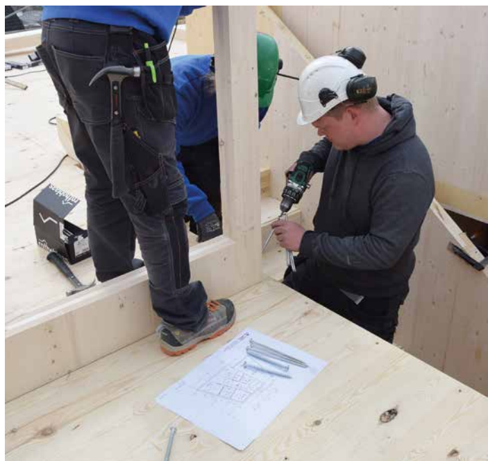
En vanlig 18V skrudrill brukes til å feste elementene.
