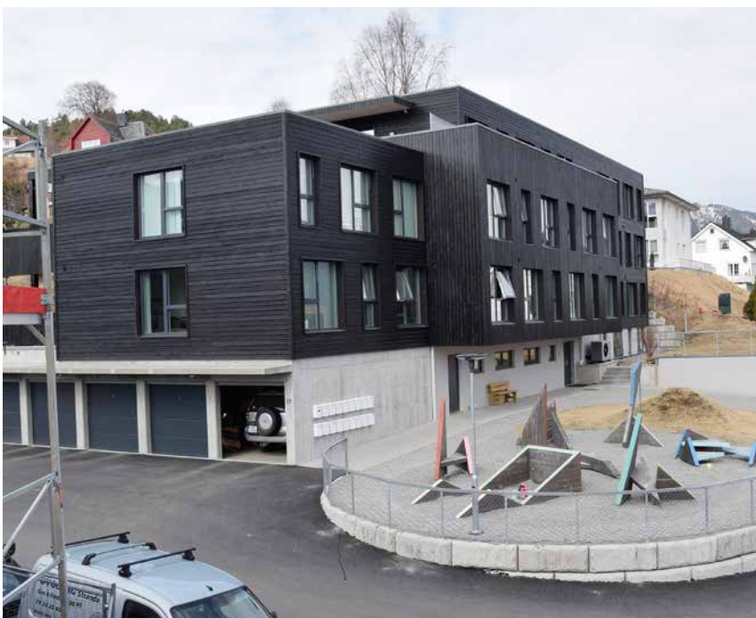
Den lille blokken rommer 11 leiligheter og er bygd med massivtre oppå garasjekjelleren.
