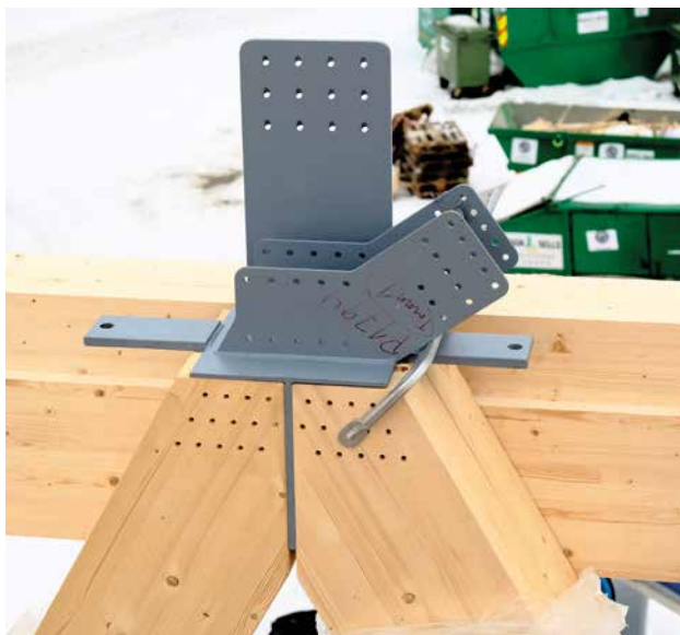
Forankring på vindkrysset i fronten av bygget.
