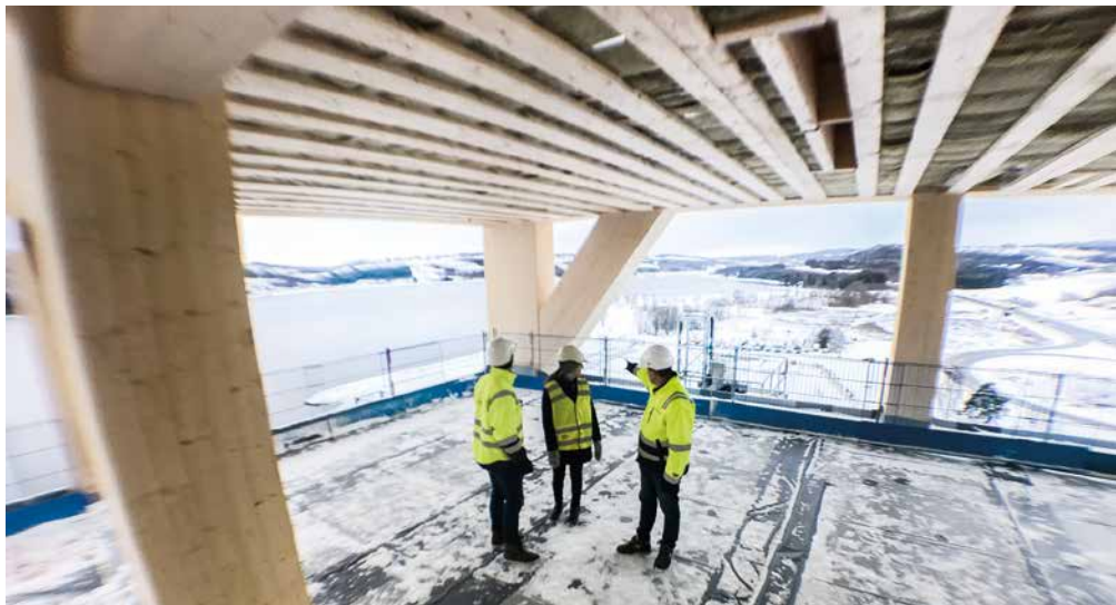
MJØSTÅRNET: Kraftige limtrebjelker og massivtre preger Mjøstårnet. (Foto: Moelven)
