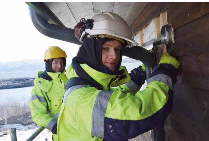
Sander Selsbakk og Lieuwe Kramer hjelper hverandre med å få på plass kledningsborda rundt en ventil og et vindu.
