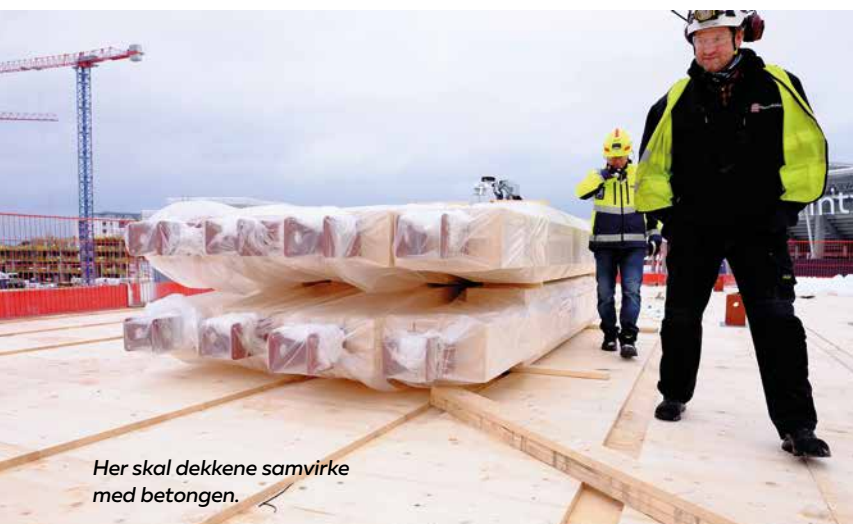
Heis- og trappesjaktene stiver av bygget.
