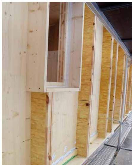
Stenderne er satt opp og det er snart klart til å legge på isolasjonsplatene.
