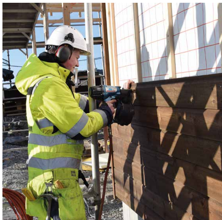
Vidar Storstrand legger på kledningsborda og må passe på at not og fjær går helt i hverandre.
