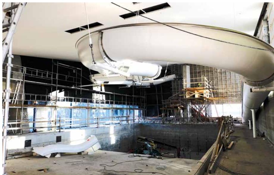
INNVEDIG: Store partier innvendig skal kles med granspilene.
