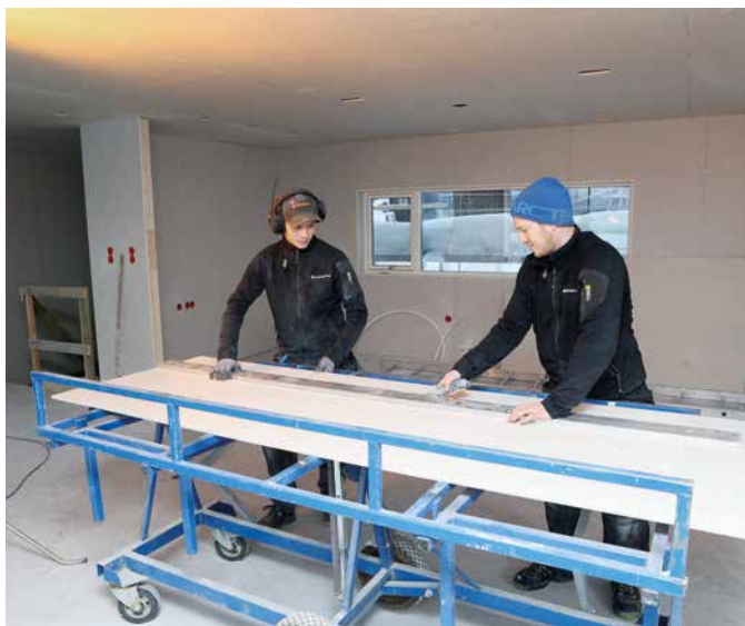
Tømrer Kjell Arne Hårstad (t.h.) gir lærling Jørgen Dahle Bakken noen tips om nøyaktighet før han skjærer til gipsen.
