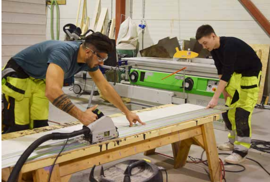
EHSAN PENAH OG ANDREAS BUSCHMANN skjærer til ei panelplate til hagestua.
