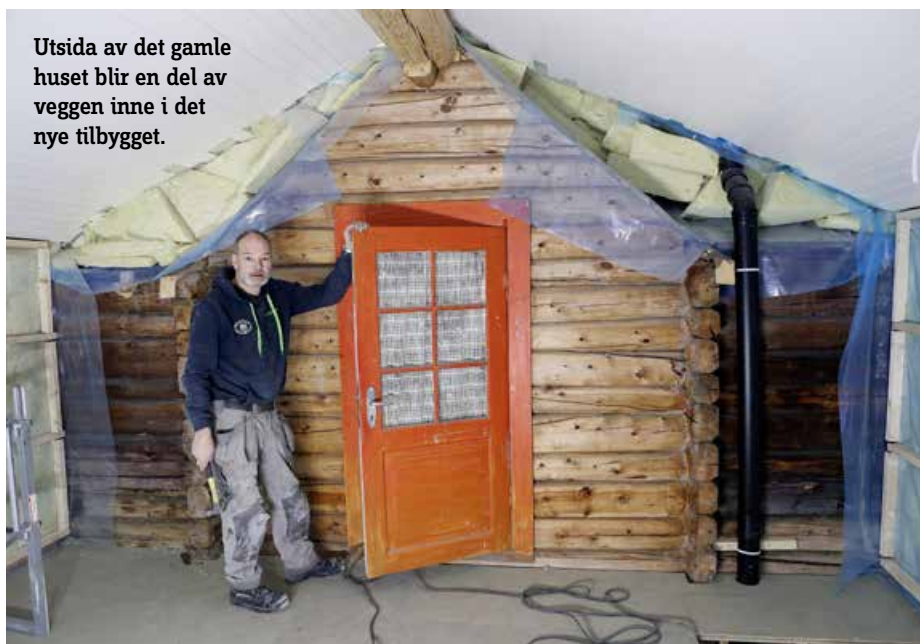
Nederst i veggén måtte en stokk byttes.
