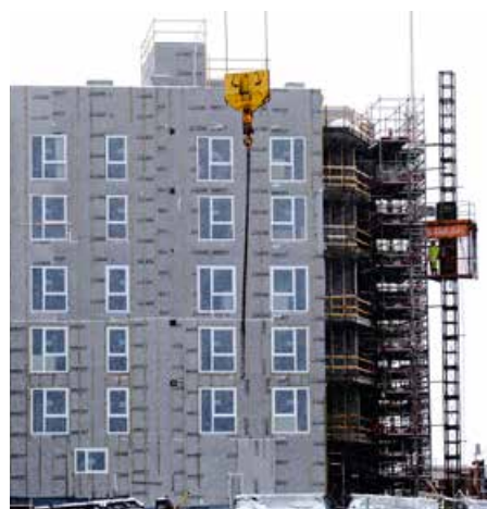
Byggekraner overalt: Lørenskog kommune har lenge ligget på landstoppen i nybygging og befolkningsvekst. Har kommunen gått glipp av mange skattekroner?
