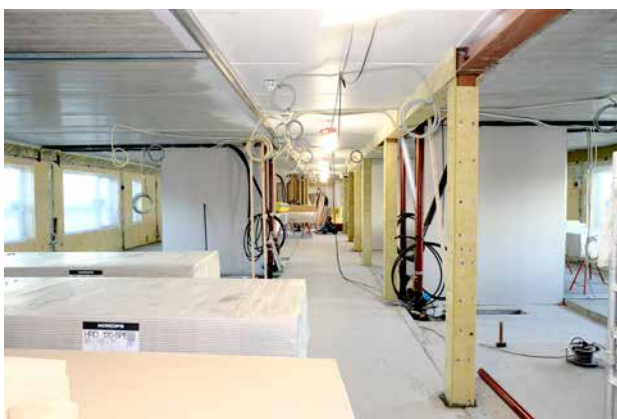
INNENFOR MARGINEN: – Rædergård Entreprenør har vært veldig dyktige her og satte opp forlegningen med en sikkerhetsmargin på en cm. Når de var ferdige var den marginen intakt, sier prosjektleder Wiklem.
