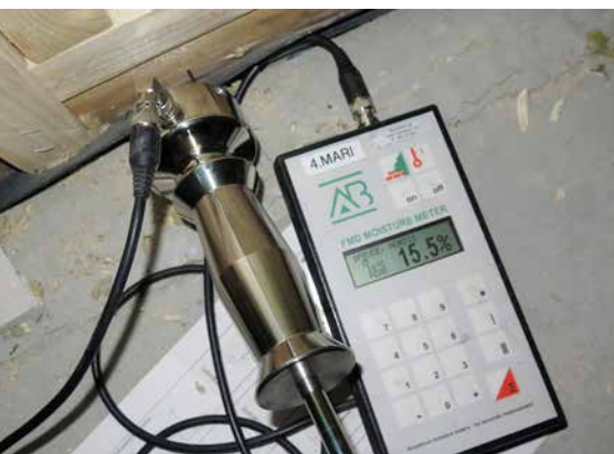
FUKTMÅLING av bunnsvill med hammer-elektrode.
