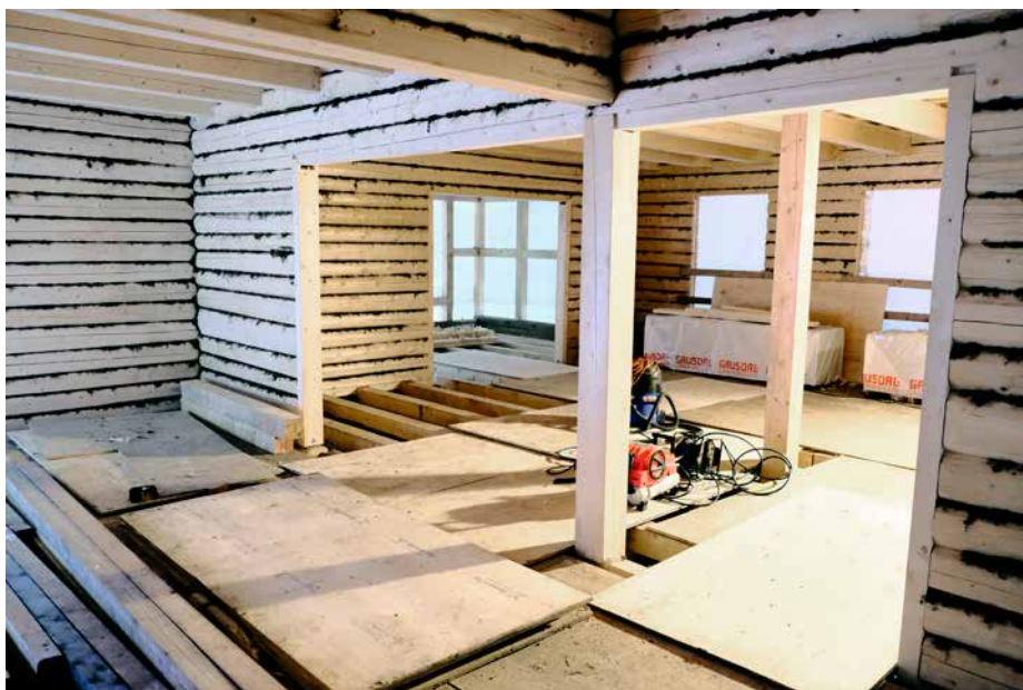
Teknisk avansert: Varme og ventilasjon er lagt i gulvet.
