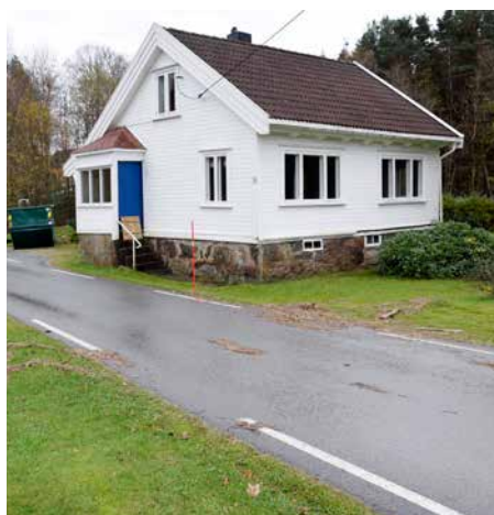
VÅTT: Det gamle tømmerhuset hadde vann helt opp til vindusbrettet i første etasje. Rusk og rask på plenen ligger igjen etter flommen som kom et par uker etter den store flommen.
