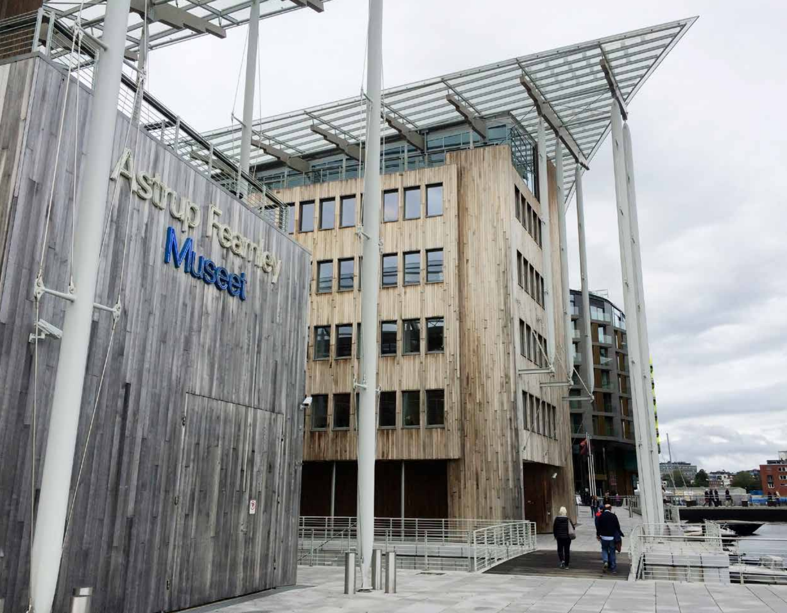
Astrup Fearnley museet i Oslo. Fasaden er av osp behandlet med jernvitriol. Bildet er fra 2016, fire år etter at museet ble åpnet.
