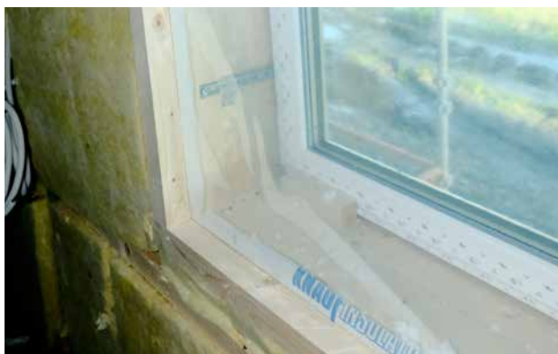
STØYDEMPING: PVC-vinduene veier 200 kilo og demper 40 desibel.
