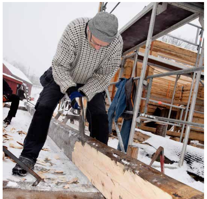
Ivar Jørstad telgjer laftestokken med ei kraftig saksleslipt bile.
