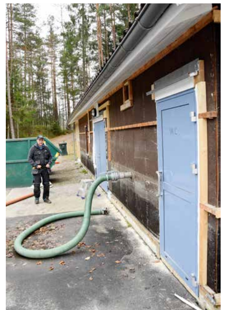
HØY VANNSTAND: Fargen på nederste del av trefiberplatene viser tydelig hvor høyt flommen sto.
