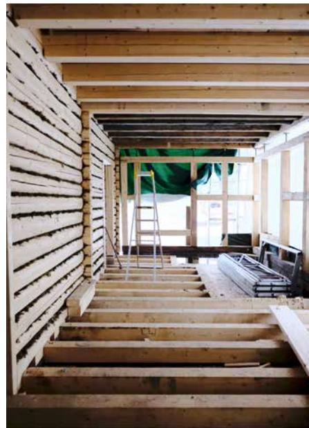
Arbeider i andre etasje.
