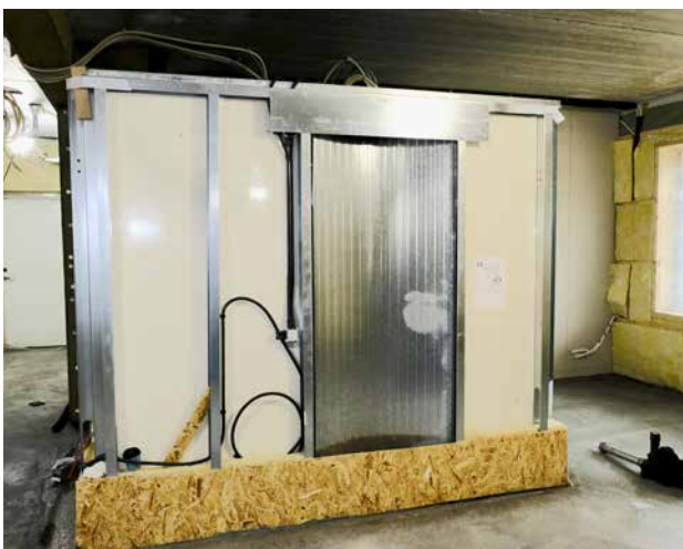
VÅTROMSMUDULER: Våtrommene kommer som prefabrikerte moduler.
