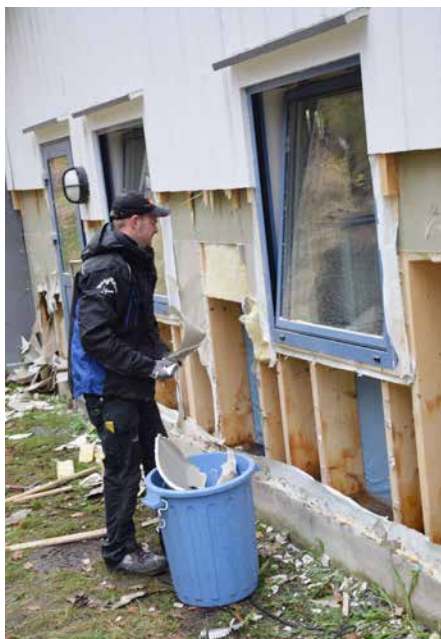
UBEHAGELIG LUKT: – Det er ubehagelig med kloakklukta innendørs, men for øvrig er dette en jobb som andre der vi river og bygger opp igjen, sier tømmer Stian Eik.
