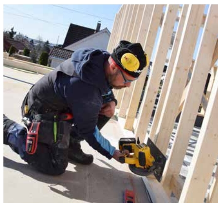
Saga blir for tung om den skal brukes til å kutte stående kledning. Høyre håndledd må vris opp og venstre hånd kommer ikke til håndtaket foran på maskinen, demonstrerer Askautrud.
