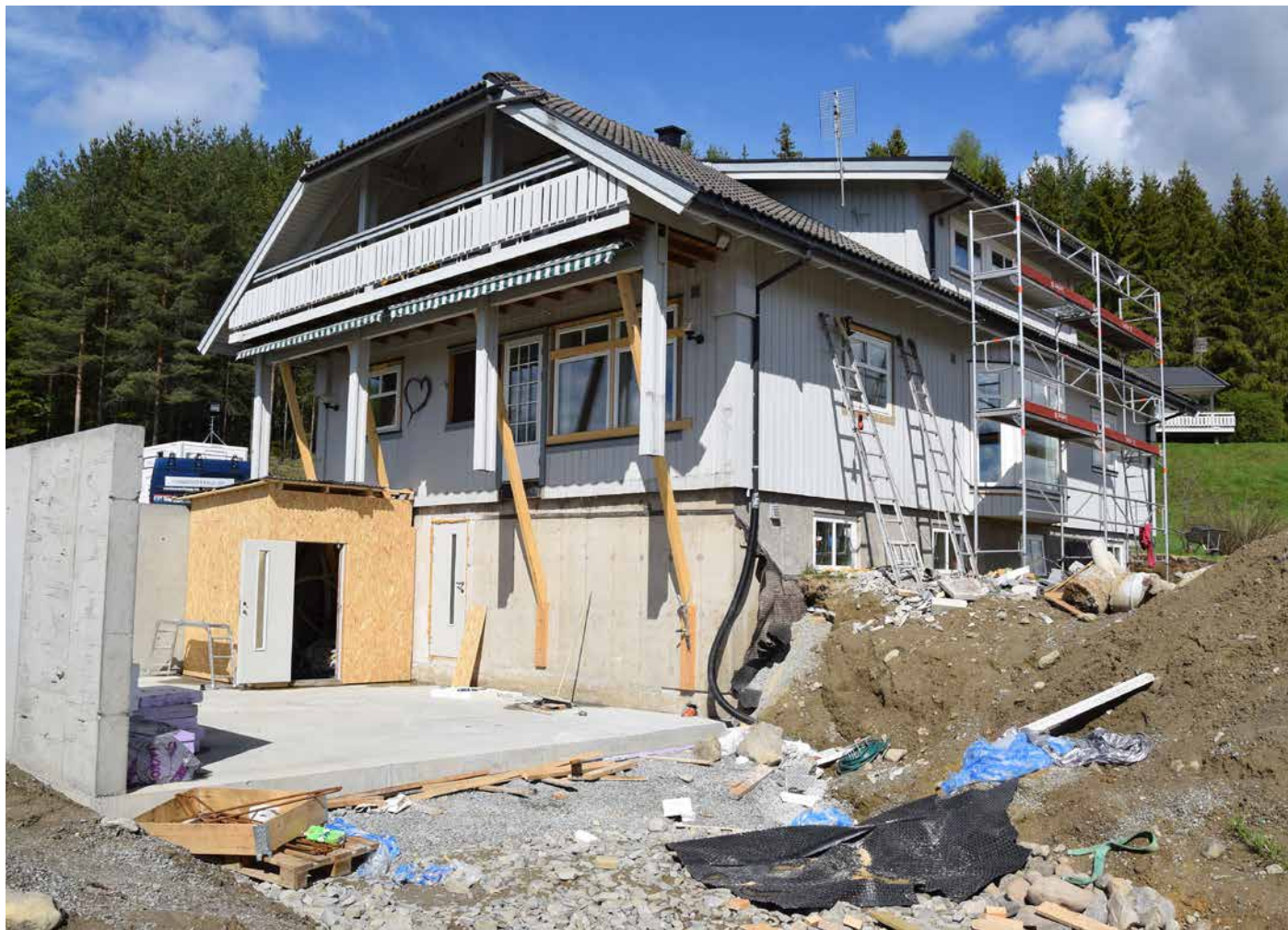
REHABILITERING: Eneboligen fra 1980-tallet gjennomgår en omfattende rehabilitering.
