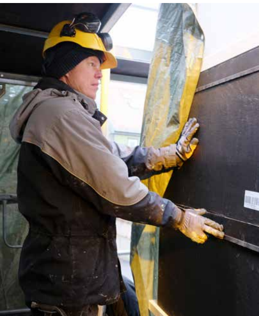
De første panelene med vakuumisolasjon monteres med en plan der hvert nummererte panel har sin plass.
