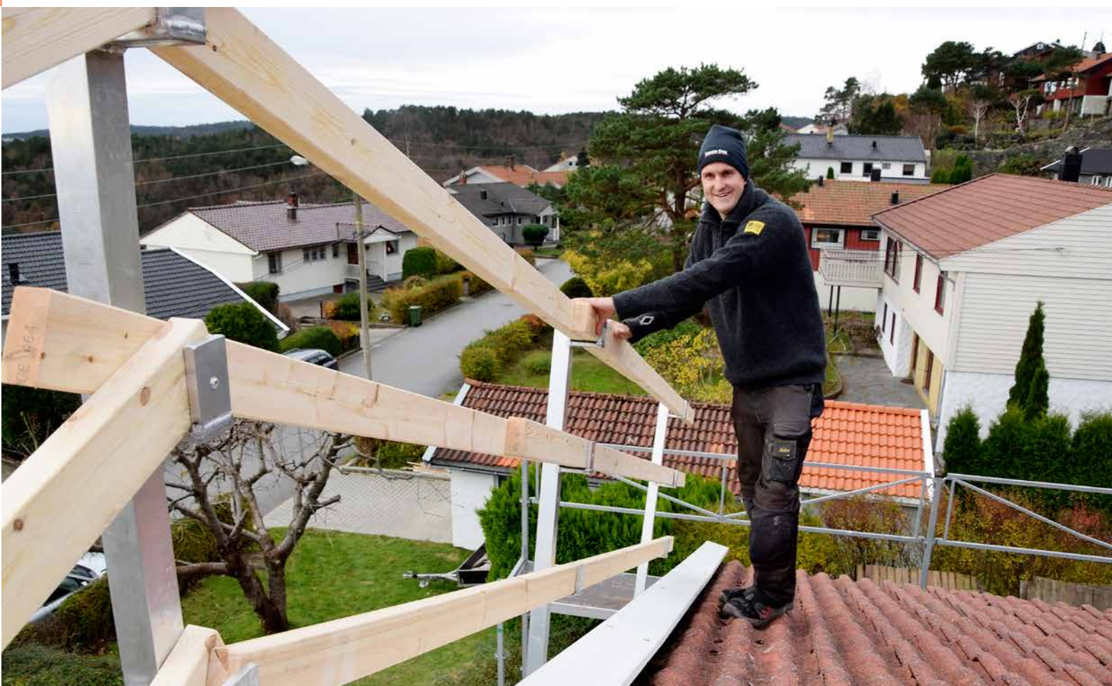
Med planker i 48 x 98 mm som fotlist, knelist og rekkverk, får vi nødvendig sikring her oppe, demonstrerer Sørheim.
