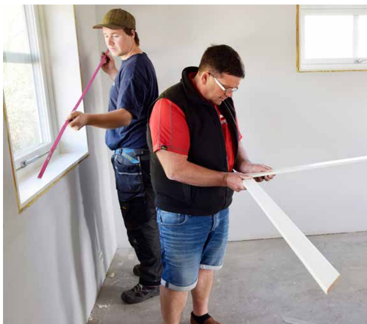
LISTING: Kent Ove Kristensen og Tom Hovedalen legger på de første ferdigkappede listene rundt vinduet.
