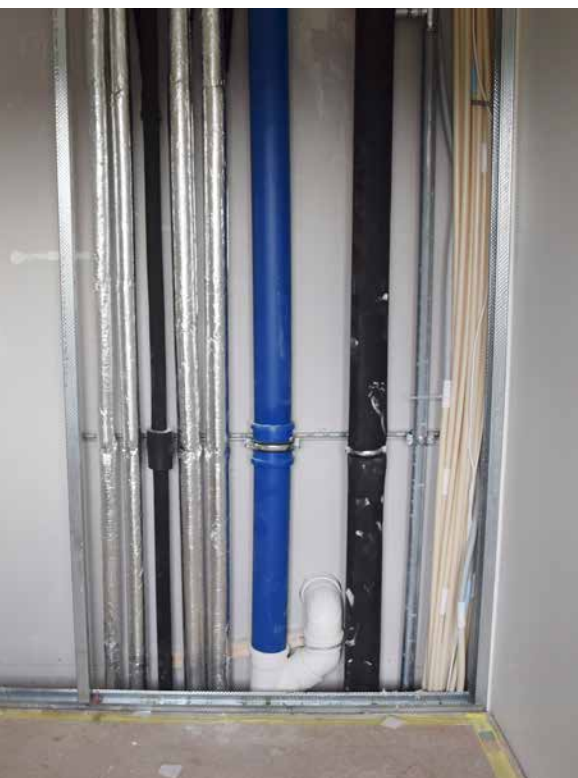
RØRSJAKT: I hovedsoverrommet blir ikke rørsjaktene tettet før elektriker og rørlegger har gjort sin del.
