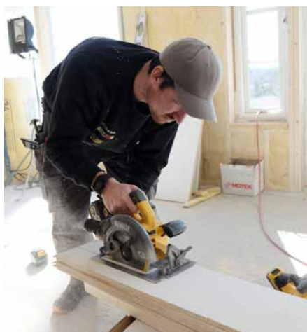
Saga freser gjennom seks himlingsplater uten problemer, konstaterer tørrmester Joakim Wiik.
