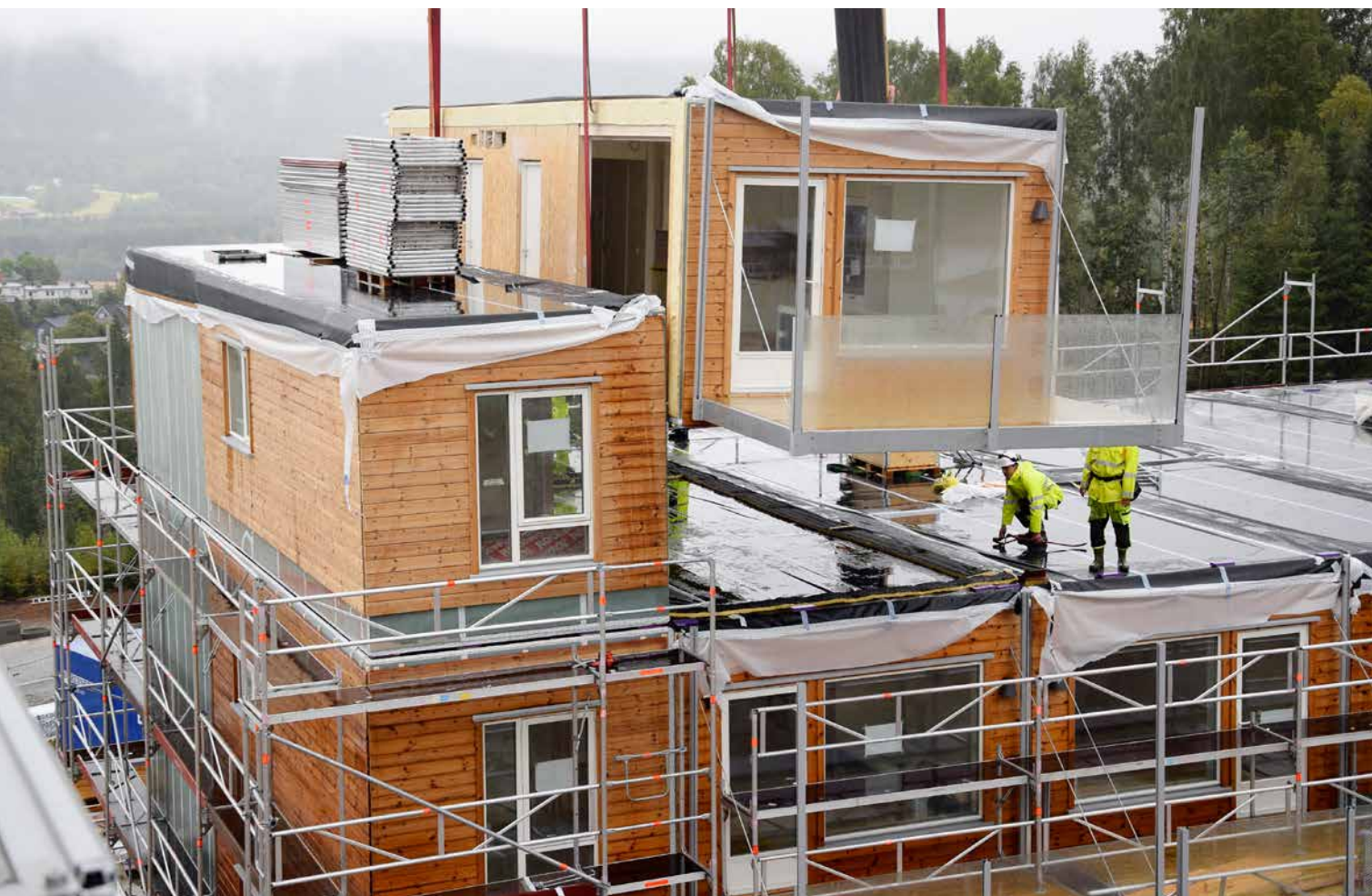
MODULENE kommer med balkongen og det ene glassrekkverket montert.
