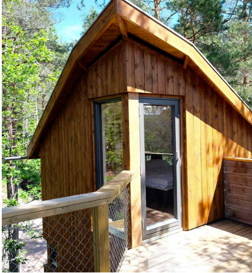
Taket på FLÅKLYPE har skrågesims og flatt tak, valm og tilpasninger. Men det er kanonbra å utføre slikt. Teknisk utfordrende, sier Dalen og Aasbø.
