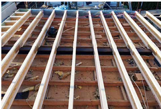
FRA RIVING OG OMBYGGING AV SALTAKET: I-bjelker ble lagt vinkelrett på de gamle undergurtene.
