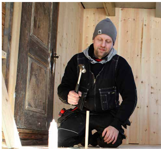
MARTIN RØSAND OG KASPER ØDEGAARD bruker treplugger over nedsenkede skruer i gulvborden i våningshuset.
