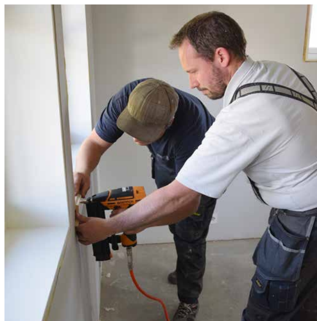
LISTING: Kent Ove Kristensen og Tom Hovedalen legger på de første ferdigkappede listene rundt vinduet.
