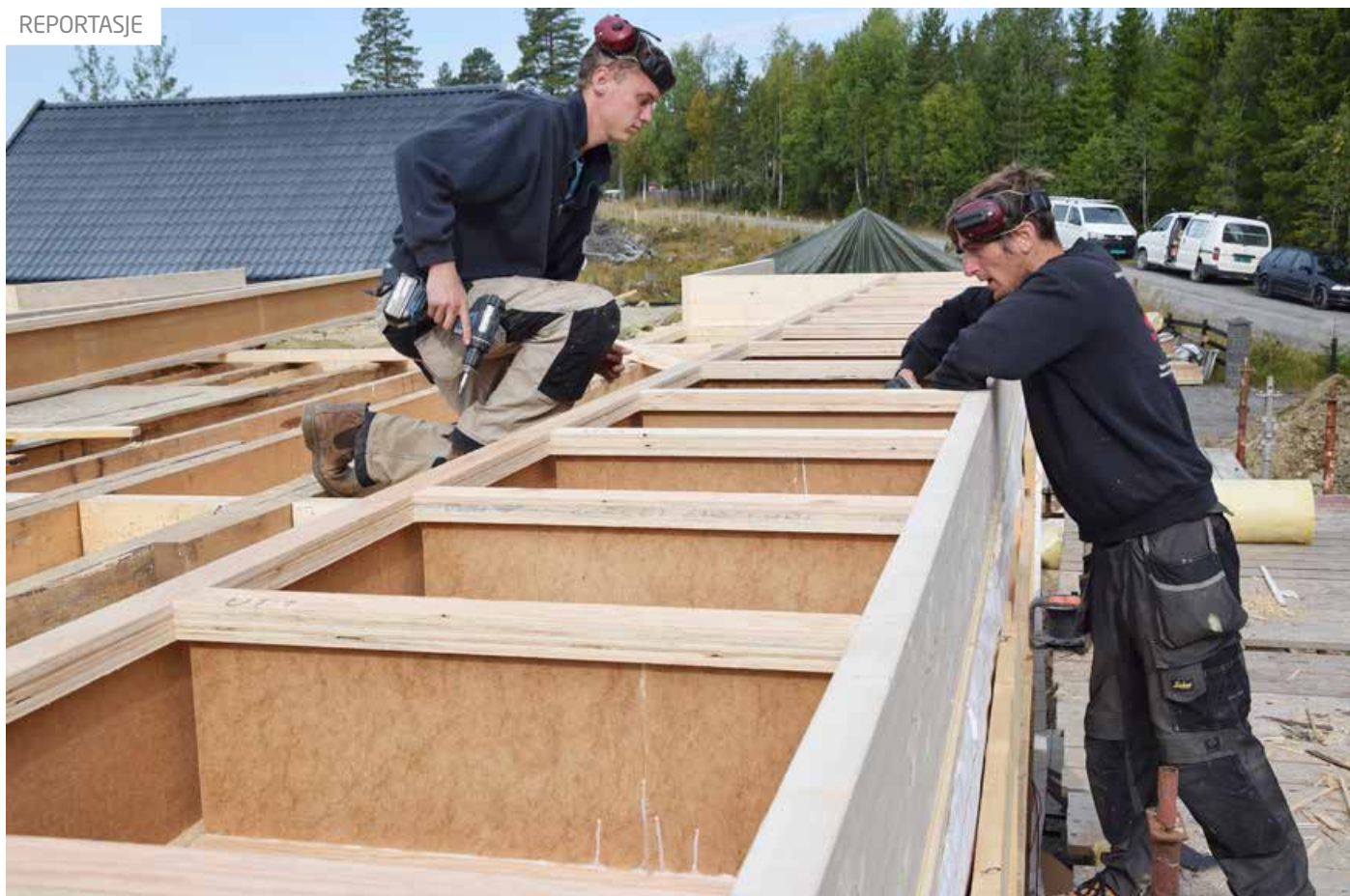
Svein Harald Nereng og Espen Bjørnerud jobber med I-bjelkene i etasjeskillet på Bjørneruds våningshus.
