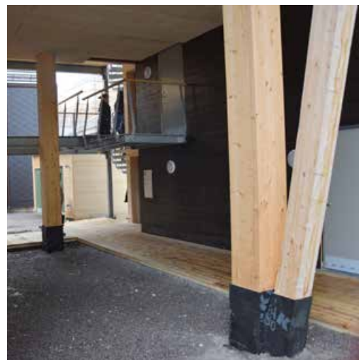
Bærekonstruksjonen er godt synlig i inngangspartiet.
