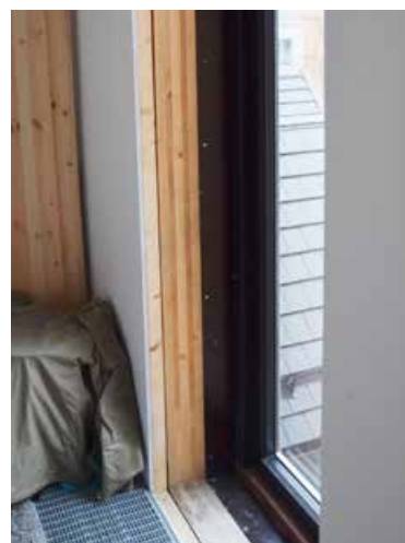
I vindusåpningen ser vi massivtre-elementene som utgjør den tyngste delen av veggkonstruksjonen.
