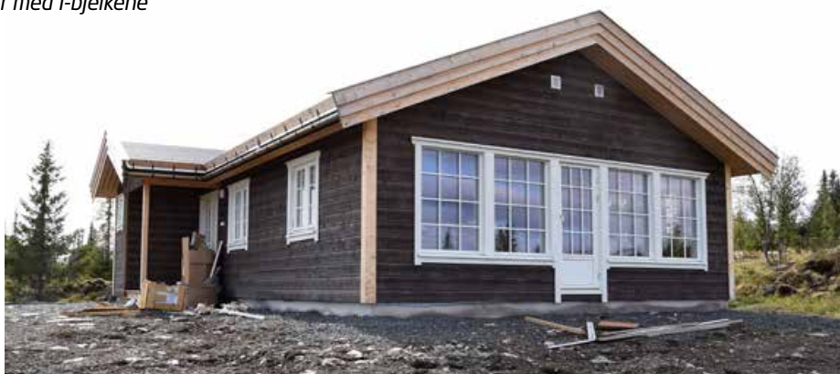
Den foreløpig siste hytta Byggmester Bjørkebakken har bygd i Synnfjell Øst, sto ferdig tidlig i høst. Kledningen er en liggende Østerdalspanel med skrå fals. På taket er det klart til å legge torv.
