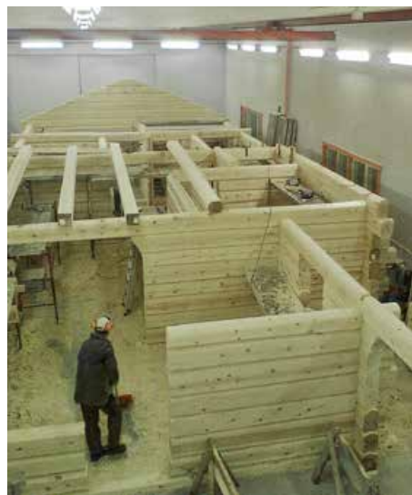
Laftingen foregår inne i laftehall, helst om vinteren. (Foto: Byfuglien)
