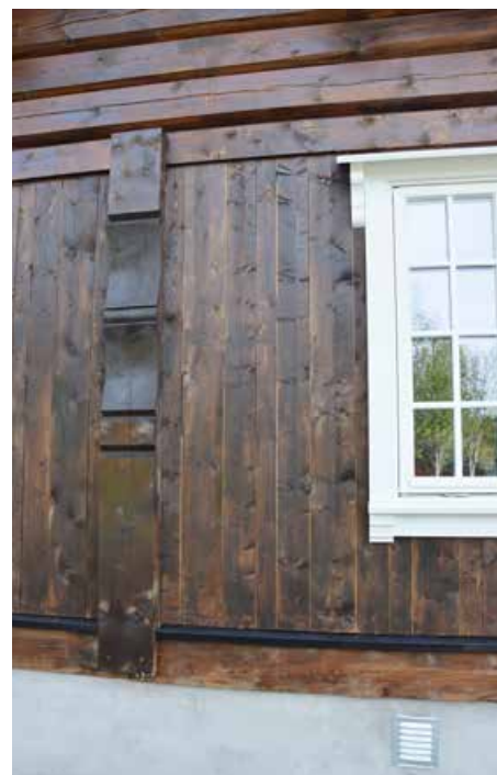
Stav og laft er en populær kombinasjon. Dekorerte stolper, vindusomramming, vindskier og søyler, er gjort til et kjennemerke.
