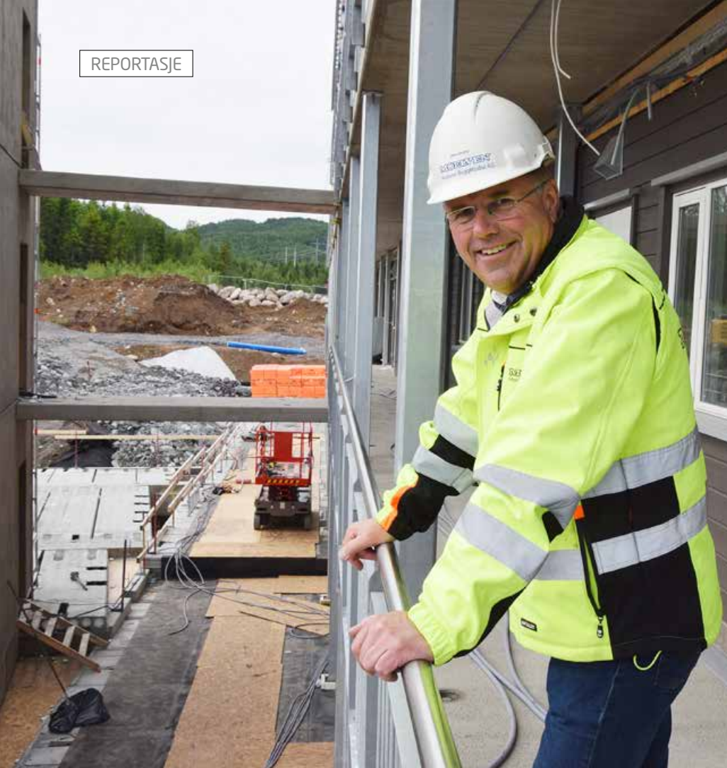
– Her i svalgangen er veggene malt med brannhemmende maling. I tillegg er svalgangene brannsprinklet, forteller prosjektutvikler Erik Langmo i Moelven ByggModul Hjellum.
