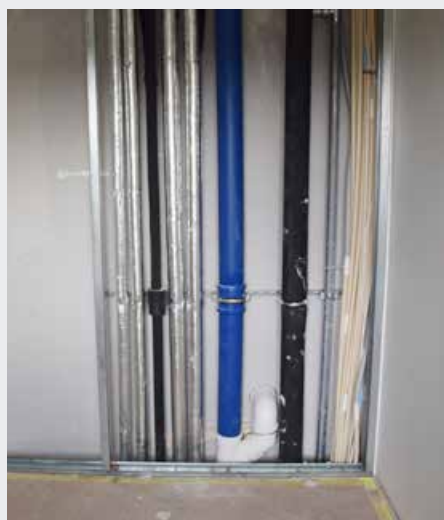
I hovedsoverommet blir ikke rørsjaktene tettst før elektriker og rørlegger har gjort sin del.
