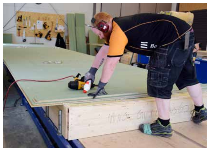
Martin Hubenthal legger på lim til den siste delen av sponplata i et etasjeskille.
