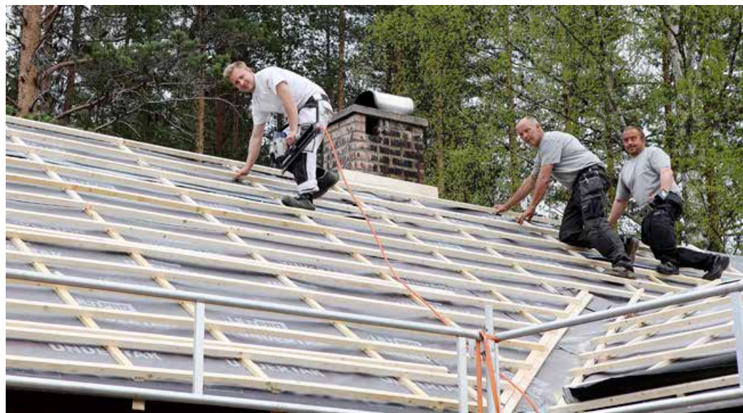
Tømmerne er kommet langt med taket.
