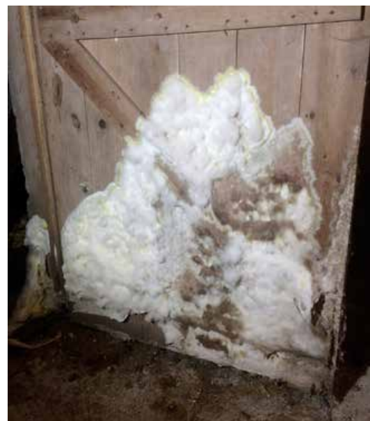
Her er hussoppen i et hus som ble rehabilitert av KH Bygdeservice. (Foto: KH Bygdeservice)
