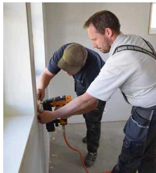
Kent Ove Kristensen og Tom Hovedalen legger på de første ferdigkappede listene rundt vinduet.
