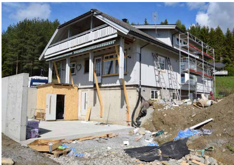
Eneboligen fra 1980-tallet gjennomgår en omfattende rehabilitering.
