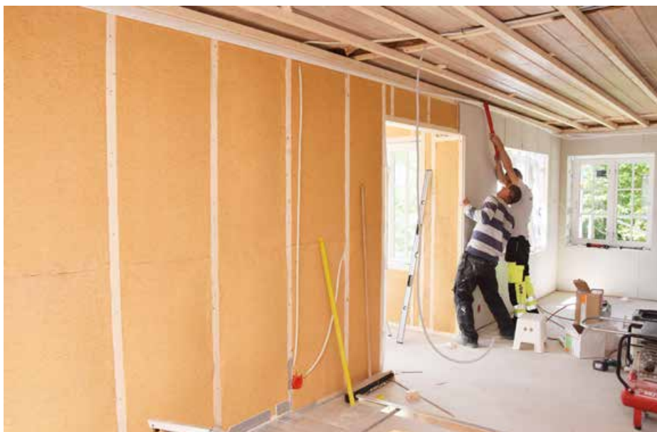
Isolasjonsmattene er faste og sitter godt mellom stenderne.
