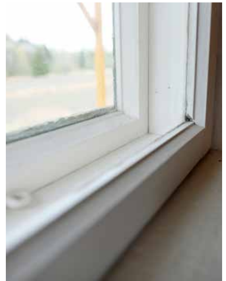
Skifte av vinduer bør kombineres med andre, nødvendige arbeider i bygningskroppen for å gi god effekt.
