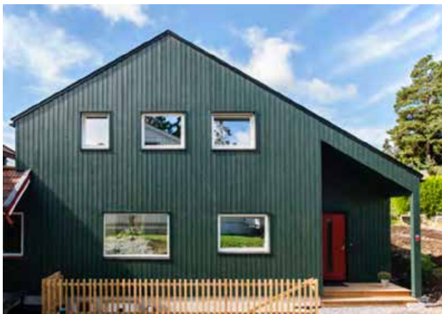
ÅRVOLL: Inngangspartiet etter oppgraderingen (Foto: J.Havran)
