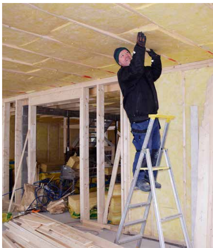
Torleiv Mandt isolerer i etasjeskillet i den store eneboligen.
