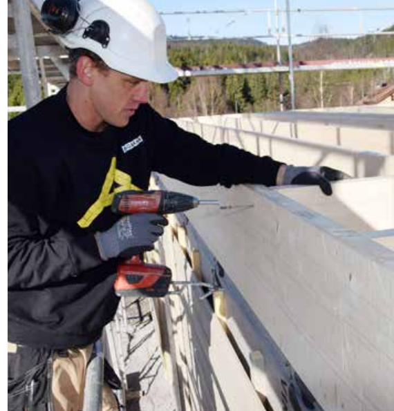
Bjelkelaget kommer i prekutt og legges på av tømmerbas Børre Sletta Olsen og kollegene.
