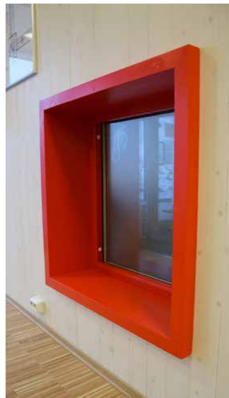
Åpningene til tre vinduer måtte skjæres ut på stedet, og var den eneste tilpasningen som var nødvendig. De var glemt i bestillingen. Alt annet ble levert som bestilt.
