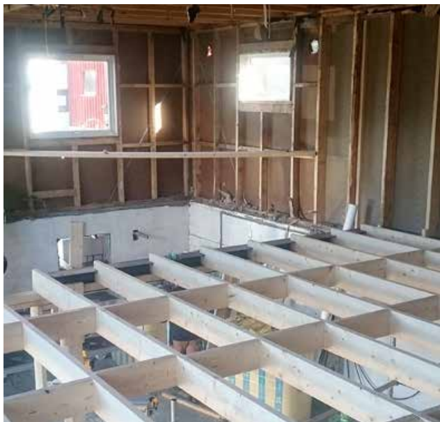
Det gamle gulvet er revet og nytt bygges opp i det eldste huset. (Foto: privat)
