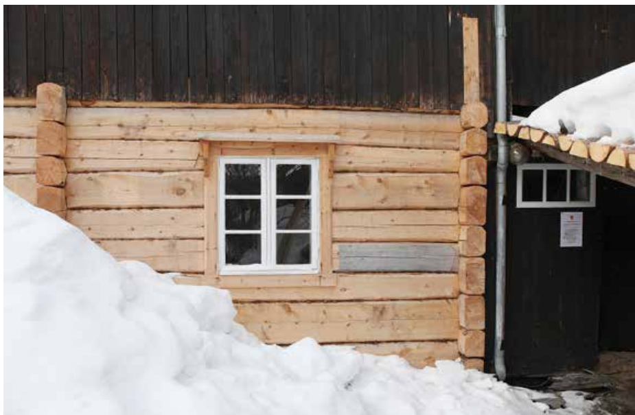
Jo Aspås har satt i stand hele første etasje – fjøset – i Skjerdingsstadgården i Røros, mest mulig slik som det opprinnelig var.
