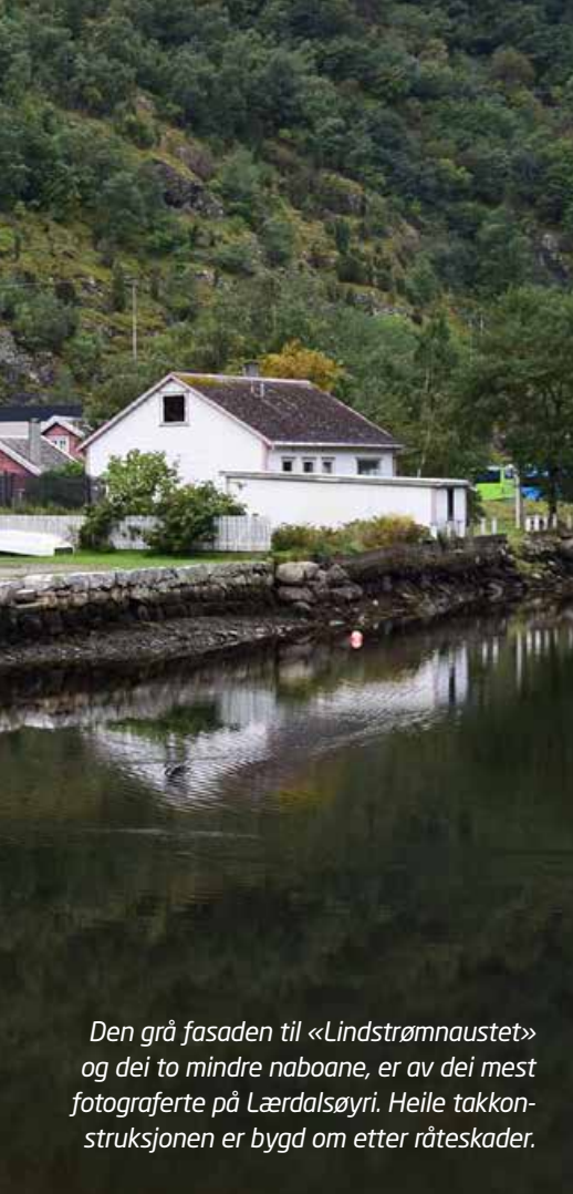
Råteskader gjorde at taket på «Henrikstova» måtte leggjast om. Dette er eitt av dei eldste husa på Lærdalsøyri, og arbeidet skjedde i nært samarbeid med byantikvaren.
