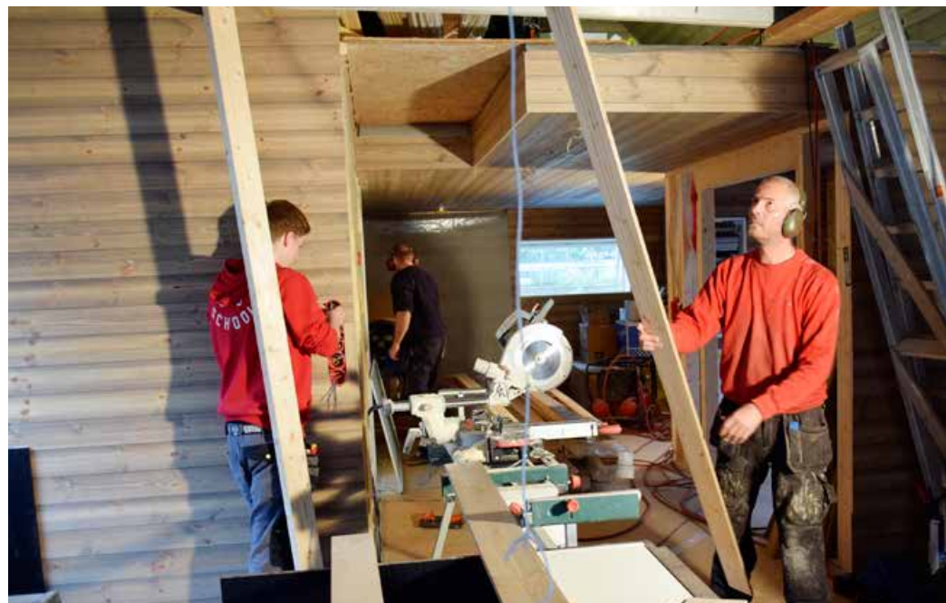
Tømrar Nils Inge Hagen og elektrikar Andreas Hagen nærmar seg slutten på arbeidet med Synneva Eris hus. Panelet er osmobehandla med kongle dekorvoks for å gje den mørke fargen.
