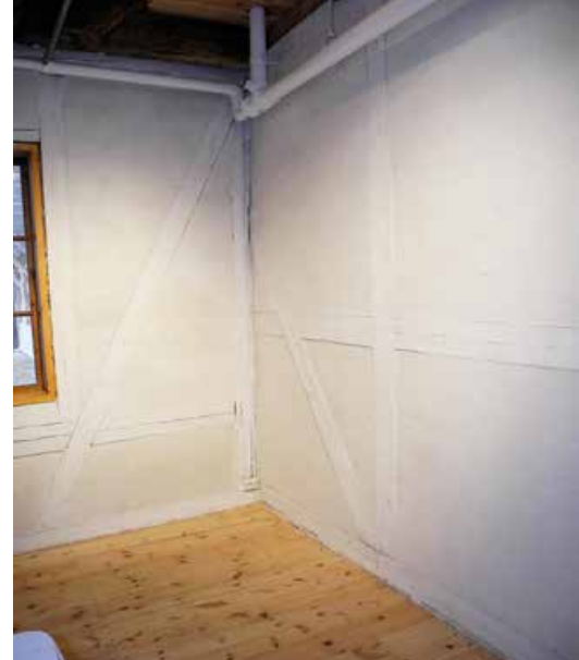
Innmurt bindingsverk er en av de gamle teknikkene som firmaet har praktisert her.
