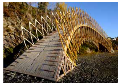
Trebroen fra KhiB er 24 meter lang og veier 4,5 tonn. Nå venter den på sin plass i Kystlandsbyen ved Austrheim.
