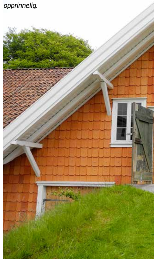
Den gamle takkonstruksjonen er restaurert og endene på taksperrene er skjært ut som opprinnelig.
