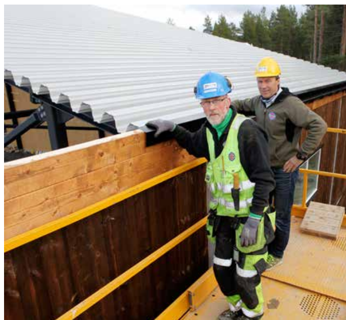
Taket er tekket med stålprofiler, forklarer Jan Kristen Kindølshaug (nærmest) og byggeleder Trond Motrøen.
