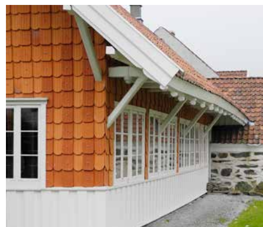
Den gamle takkonstruksjonen er restaurert og endene på taksperrene er skjært ut som opprinnelig.
