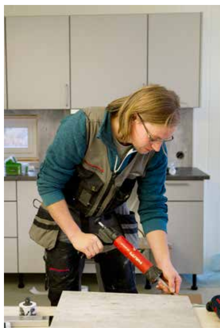
Tor Martinsen platekler deler av kjøkkenveggen.
