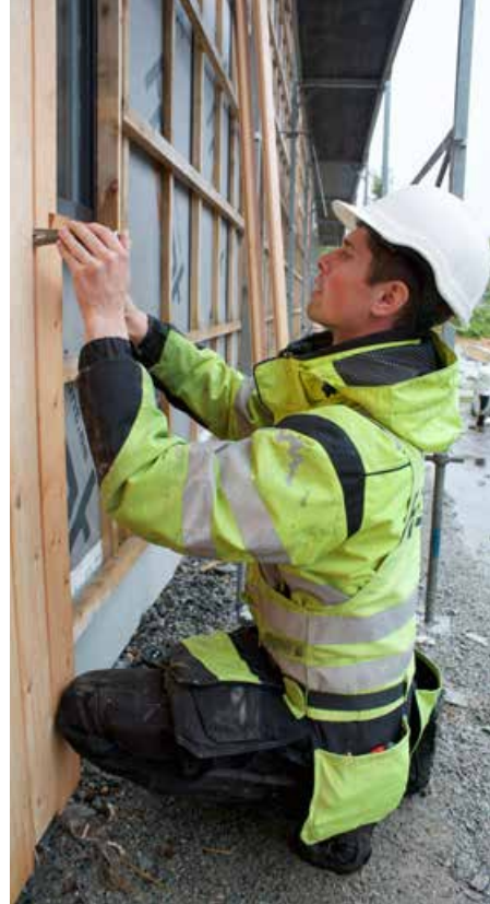
Marius Egeli tar siste finpuss på utvendig kledning.
