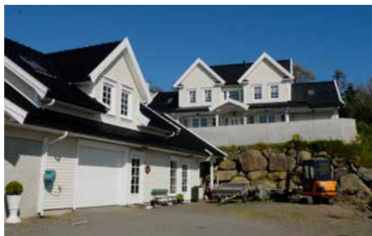
Bolig og garasje med leilighet i amerikansk stil ligger på Vanse. Boligen har en grunnflate på ca 150 kvm, garasjebygget har leilighet med en grunnflate på vel 100 kvm. På bildet ser vi bare halve garasjen.
