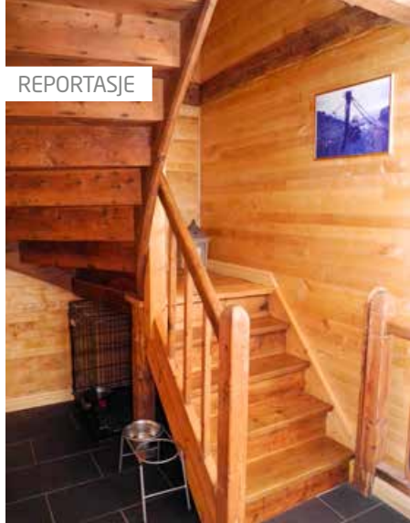
Trappeåpningen måtte utvides for å få plass trappa fra Ludeboden.
