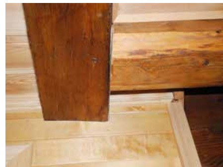
Panel «krabber» rundt de skeive bjelkene i himlingen.
