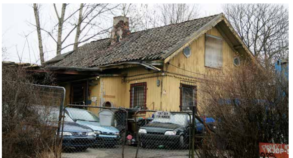
Fasade sett fra vest før demontering i februar 2015. (Foto: Tandberg Arkitekter)
