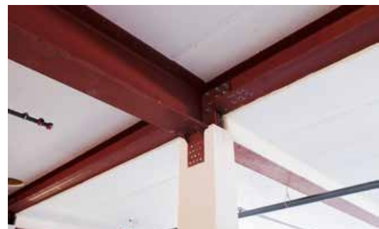
På et sted i bygget var det nødvendig med bæring i stål for å komme fram med ventilasjonsrør. – Skulle vi løst dette med gjennomføringer i trebjelker akkurat her, ville de blitt for høye, sier Johansen.
