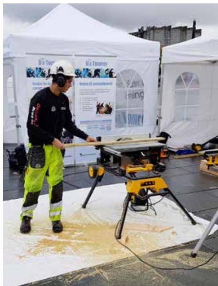
Nicolai Mahesan fra Mårstig Bygg i aksjon. (Foto: Knut Bjørkheim /Byggmestrenes Servicekontor AS)
