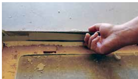
Massivtredekket med et 35 mm isolasjon og påstøp med sparkel.
