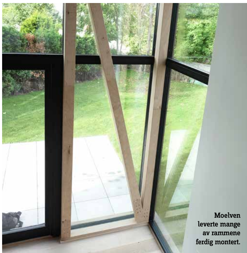
– Ribordet som du ser i underkant klarte vi ikke å feste ved å bore inn utenfra, viser Tyskeberg.
