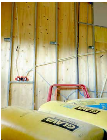
– Vi forer ut veggene her med 70 mm isolasjon og det sikrer at veggene med påføring ivaretar lydkravene horisontalt.
