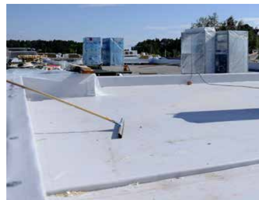
Det flate taket er også i massivtre og alt fall er lagt i isolasjonen.
