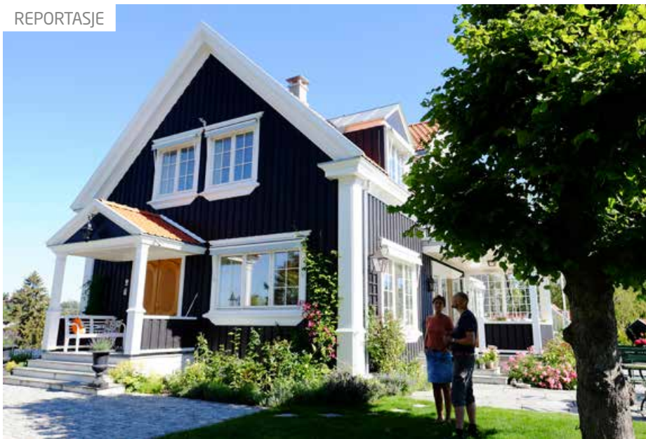
Arkitekt Helge Løkeland og eierne var inspirert av en villa i Trondheim fra 1909.
