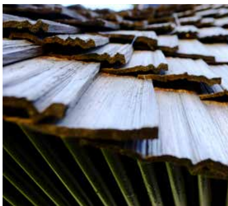
Sponen fra Norsk Spon i Trøndelag er splittet, ikke skåret. Det ville åpnet fibrene for vann og gjort bygget mer sårbart. Sponen er innsatt med jernvitriol og pigmentet kjønnerøk (lampesort). De er lagt i god og luftig overlapp, slik at fasaden forblir tett og tårker fort.
