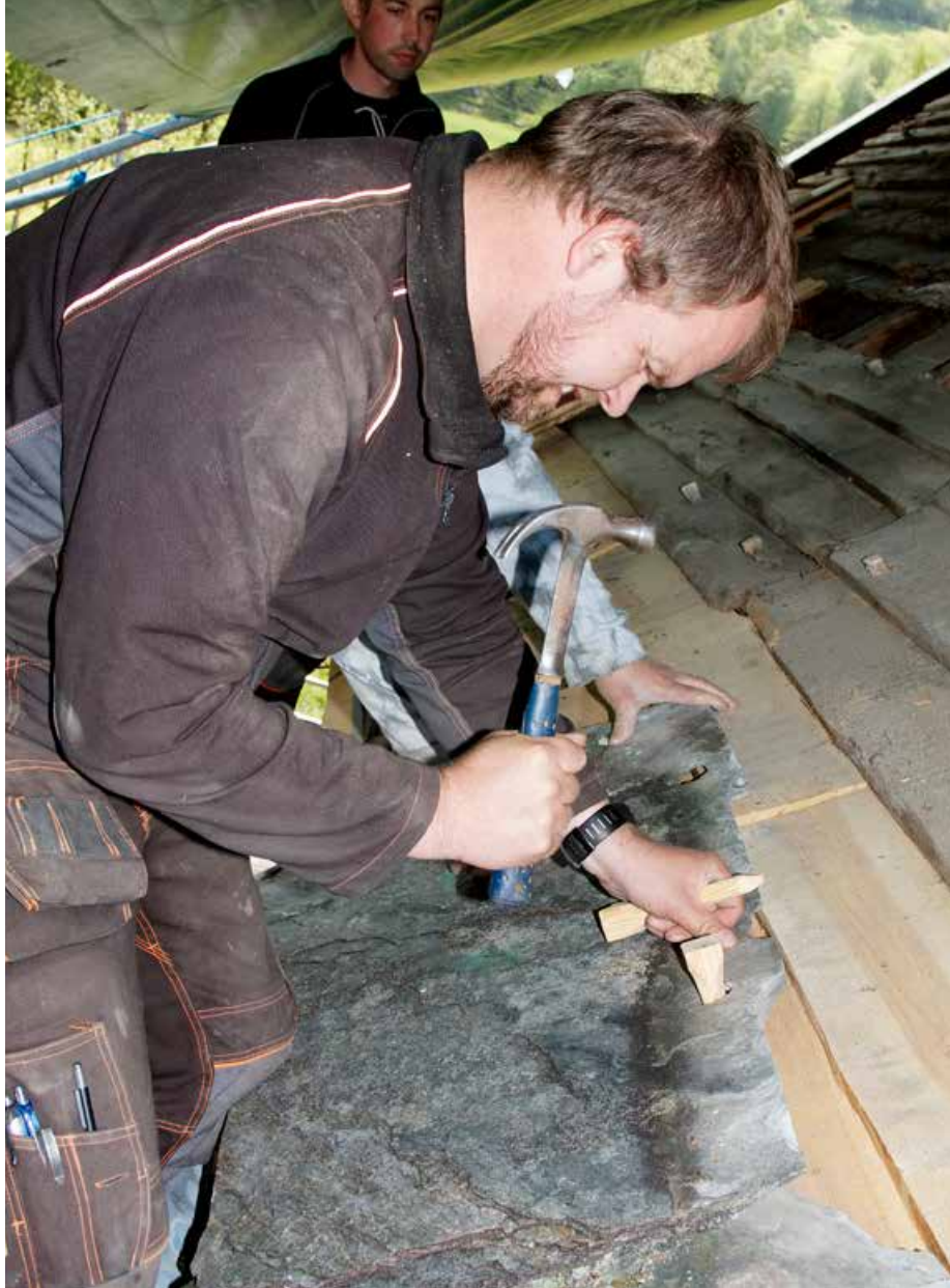
Kjell Gunnar Haraldseid banker på plass en trenagle til takhellen. I alt ble det brukt 4.500 håndspikkete nagler på låvetaket.
