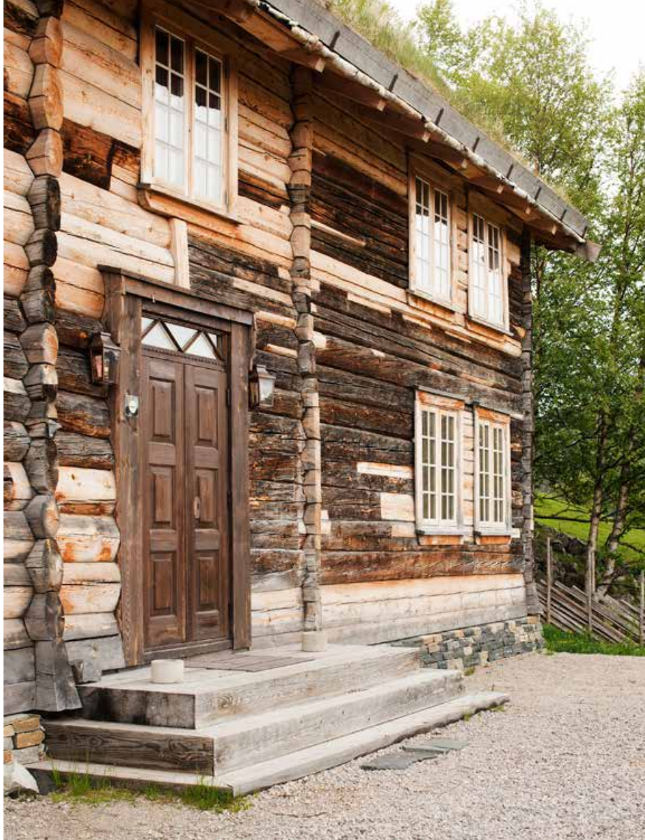
Både hus og loft stod opprinnelig på gården Uppstad i Valle, og er flyttet en gang før de ble flyttet Fjellgarden Hovden der Straume Handlaft har restaurert begge bygningene. Å plukke ned og bygge opp igjen bygningene tok et drøyt halvt år.
