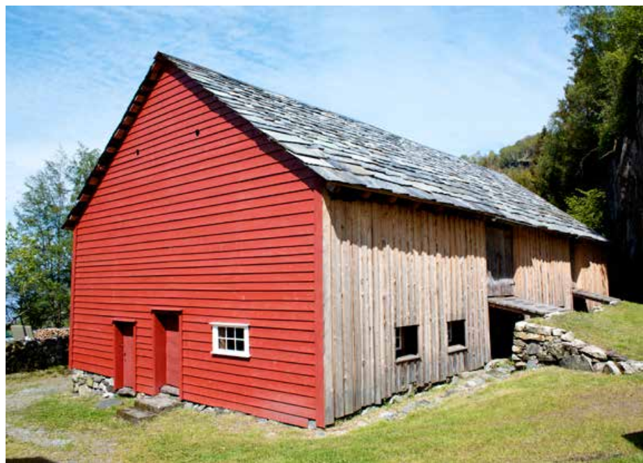
Låven på Vigatunet i Hjelmeland er ferdig rehabilitert av museumshåndverkerne fra Ryfylkemuséet. Bare fronten er malt, slik skikken var i gamle dager da maling var dyrt.
