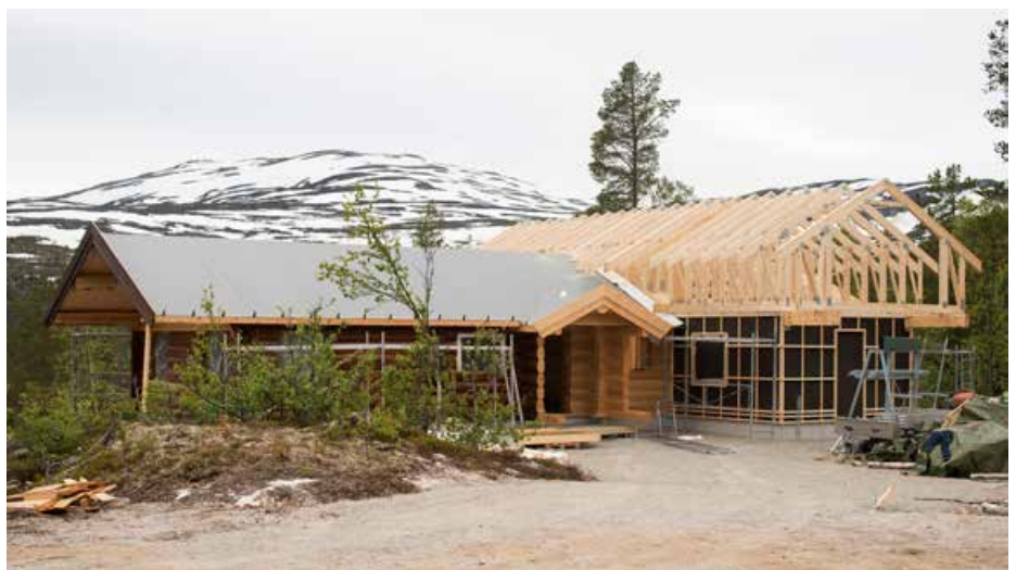
For å få hyttene rimeligere, har Olav Straume utviklet en modell med én tredjepart laft og resten vanlig bindingsverk. Det er gjerne stua som er laftet. Ellers er det vanlige vegger, som kan kles på forskjellig vis.
