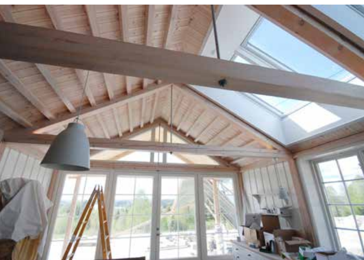
Timber Bygg leverte en veldig flott konstruksjon, stivet av med ståltag hele veien. (Foto: Topos arkitektur og design)
