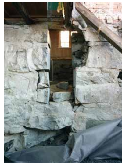
– Steinmuren ga utfordringer da vi skulle bryte kuldebroer, vi måtte kalle inn et spesialfirma til å skjære steinen med wiresag, sier Tore Ringstad.
