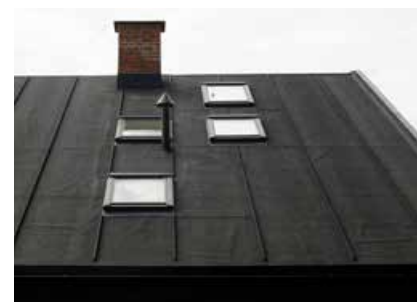
– Taket har fått mellom 30 og 50 cm isolasjon. Så fjernet vi de gamle taksperrene og hevet taket på to bad opppe som var litt trange, sier Olsen.
