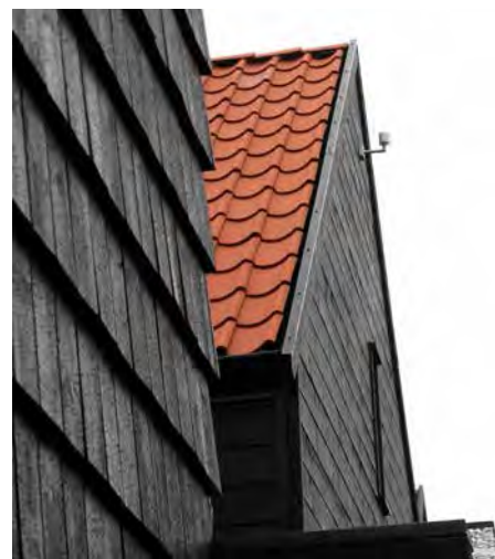
I åpningen mellom takstein og vindskier ligger ei renne. Åpningen skal være stor nok til at rensing av renna går greit.
