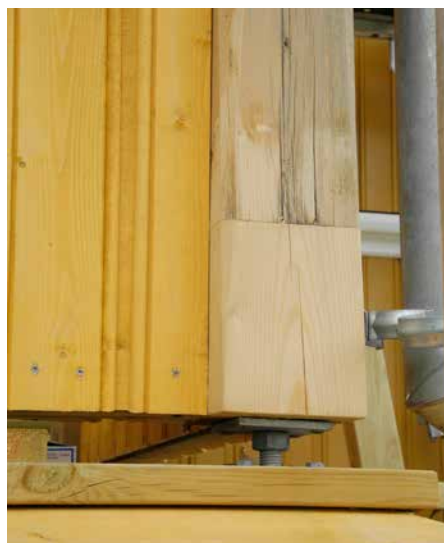
Råteskadde stykker er skiftet ut med friskt tre der det var nødvendig.
