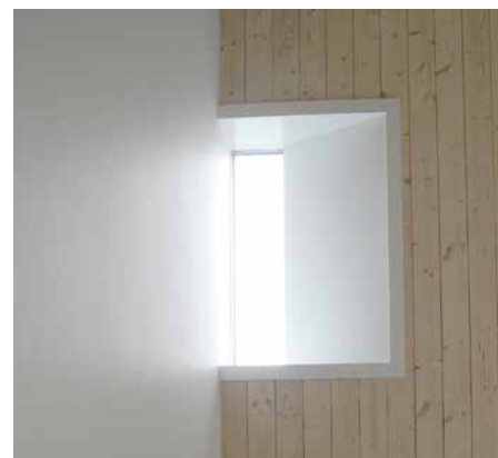
Takvinduer, lyssjakter og klosteskår-åpninger er brukt for å gi lys innover i rommene.
