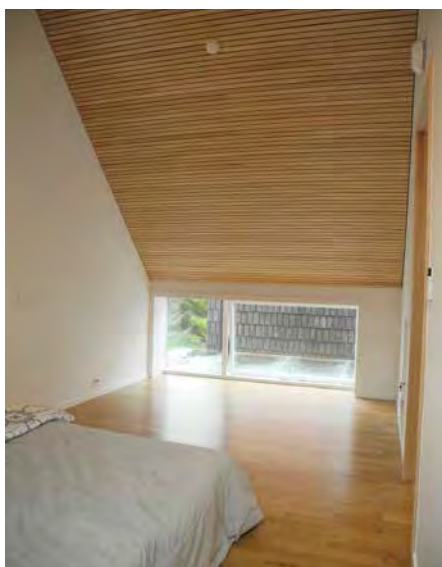
Weatherboard-kledning og spilekledning i himlingen er brukt inne for å vise at begge har en lyddempende effekt.
