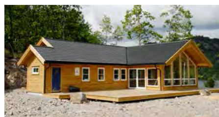
En driftsbygning og ei hytte er to av byggeprosjektene firmaet nylig har hatt.
