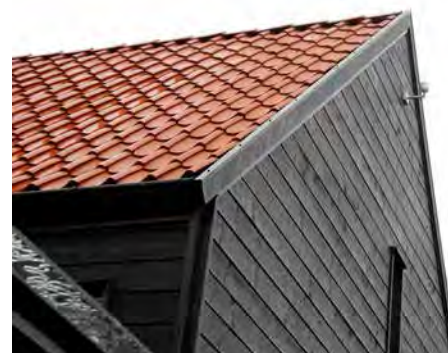
Liggende låvepanel, hjørnekassene og vindskiene er resultat av samarbeid mellom byggmester og arkitekt.
