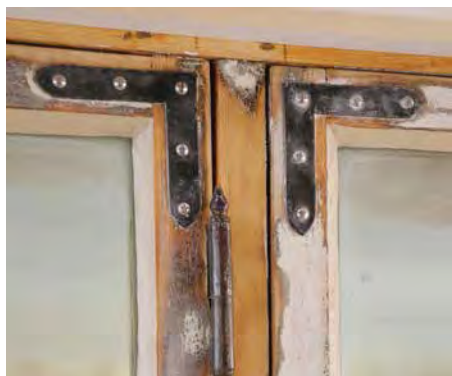
De originale vinduene er på plass igjen etter restaurering i verkstedet.
