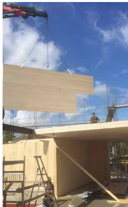
Massivtre-element heises på plass i det store huset ved Ringvebukta. (Foto: Trio-Bygg)
