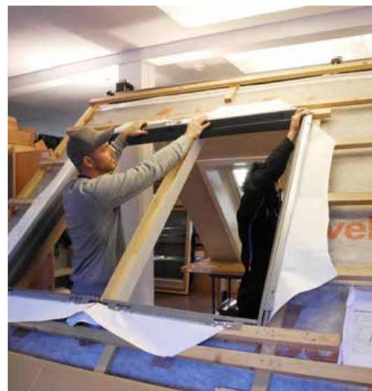
- Greit å friske opp kunnskapen før vi skal i gang med en ny jobb, sa Kristoffer Hvass Evju på monteringskurs i vinter.
