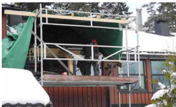
Et enkelt presenningstak over åpningen var nødvendig for å holde nedbøren ute.
