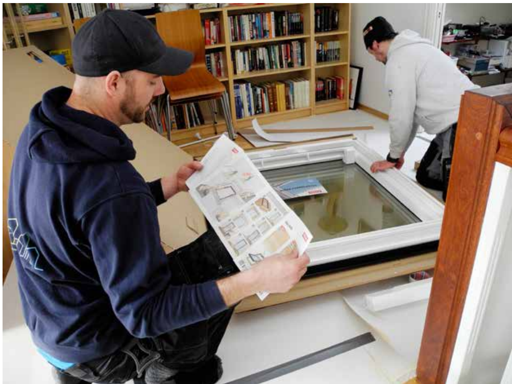
Kristoffer Hvass Evju sjekker monteringsanvisningen, mens Martin Steen skal sette på festebeslagene.
