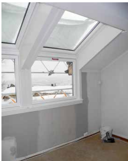
Noe malerarbeid gjenstår før jobben med vinduene kan anses ferdig. En stålbeilke i takkonstruksjonen forhindret at overkant på foringen ble vannrett som ønskelig.
