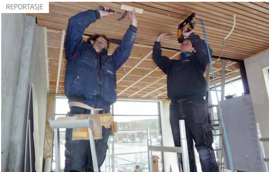
Tømmerbas og byggeleder Anders Jonskaas (t.v.) og tømmerlæring Joakim Isaksen monterer eikespiler som skal dekke hele himlingen i stua.
