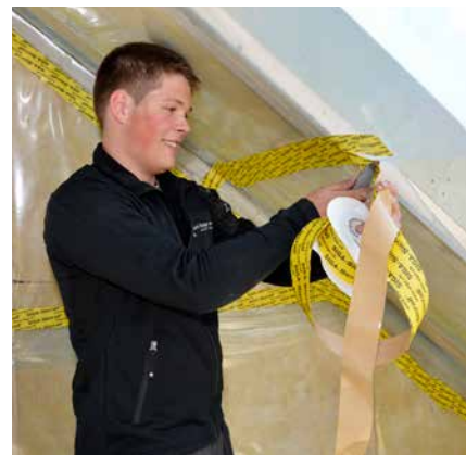
Tømrer Karl Løvås legger fuktsperre og lærling Paul Espeland teiper og skjører fuktsperren i den nye eneboligen.
