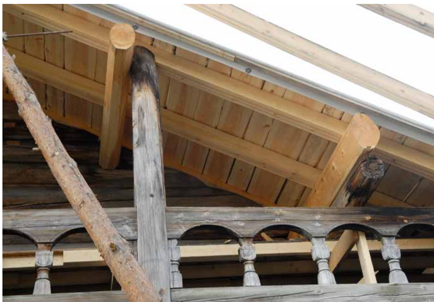
Nye materialer blir brukt der det er nødvendig for å opprettholde bærende funksjon.
