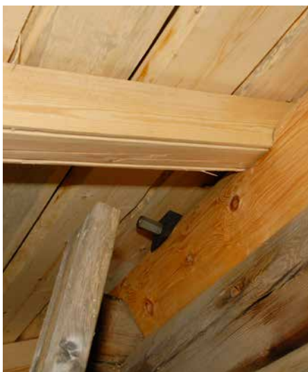
Litt moderne teknikk må til. Her kan vi skimte en jerndrager som forsterker konstruksjonen.
