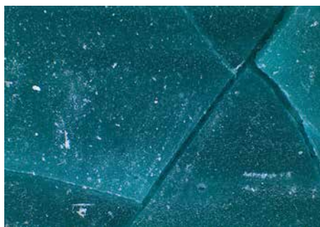
Membran tatt ut fra baderom med fuktskader. Membranen blir glass-sprø ved fuktpåvirkning, den sprekker og slipper fuktighet igjennom.
