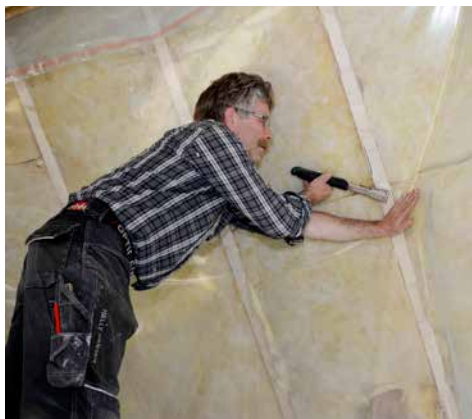
Tømrer Karl Løvås legger fuktsperre og lærling Paul Espeland teiper og skjører fuktsperren i den nye eneboligen.
