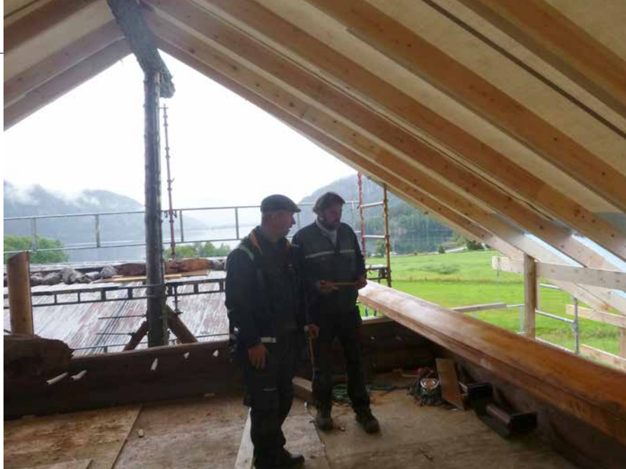
Bygg- og tømrermester Hallvard S. Nomeland og tømrer Øyvind Mauren arbeider med det nye taket.
