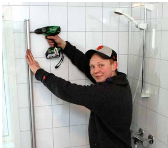
Marius Kværnes monterer dusjkabinett i baderommet som han har restaurert fra tak til gulv.
