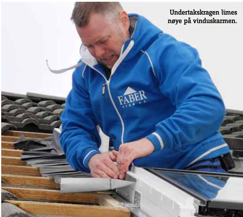
Morten Gjerde har lang erfaring med å sette inn takvinduer, men bruker ofte monteringsanvisningen for å være sikker på at det gjøres riktig.
