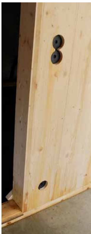
Elementer med integrerte elektriskrør og -bokser gir spart tid. Utlekking blir ikke nødvendig for å innpasse ledninger og bokser.
