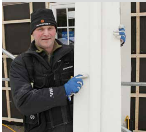
– Slik skal barokk kledning monteres, med to brede underliggere og et smalt og profilert over, viser Vegar Finstad.
