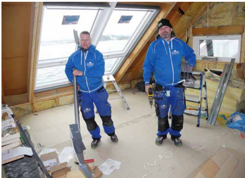
Tette- og beslagssystemet består av mange deler, men de er sortert i pakker tilpasset monteringen, forklarer Atle Dåstøl og Morten Gjerde med noen av beslagsdelene.
