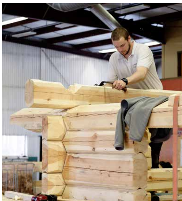
Med en god bandkniv blir laftet tett og fint.
