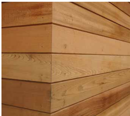
Boligen er kledd med sedertre, og alle hjørnene har pene avslutninger hvor bordene er kuttet i 45 grader mot hverandre.
