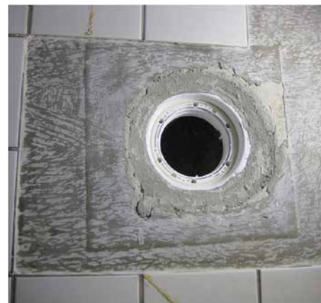
Fliser er fjernet og flislimet slipt/pusset bort.
