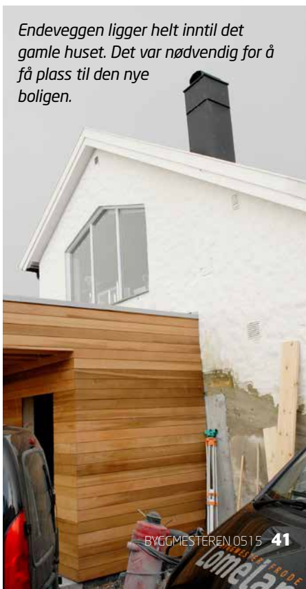
Boligen er kledd med sedertre, og alle hjørnene har pene avslutninger hvor bordene er kuttet i 45 grader mot hverandre.
