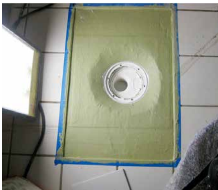
Ny smøremembran er påført, med overlapp mot eksisterende.
