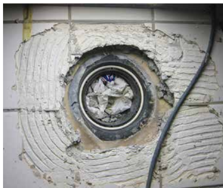
Eksempel på lokal utbedring ved sluk. Sluket er frigjort. (Foto alle slukbilder: Norwegian Claims Link)
