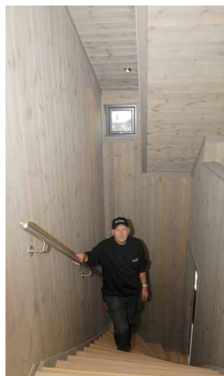
Byggmester Ola Birger Trydal viser at det er stor høyde over trappen fra første til andre etasje.
