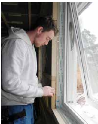
Den ferske svennen Martin Finstad er nøye når han tetter med teip rundt vinduene.
