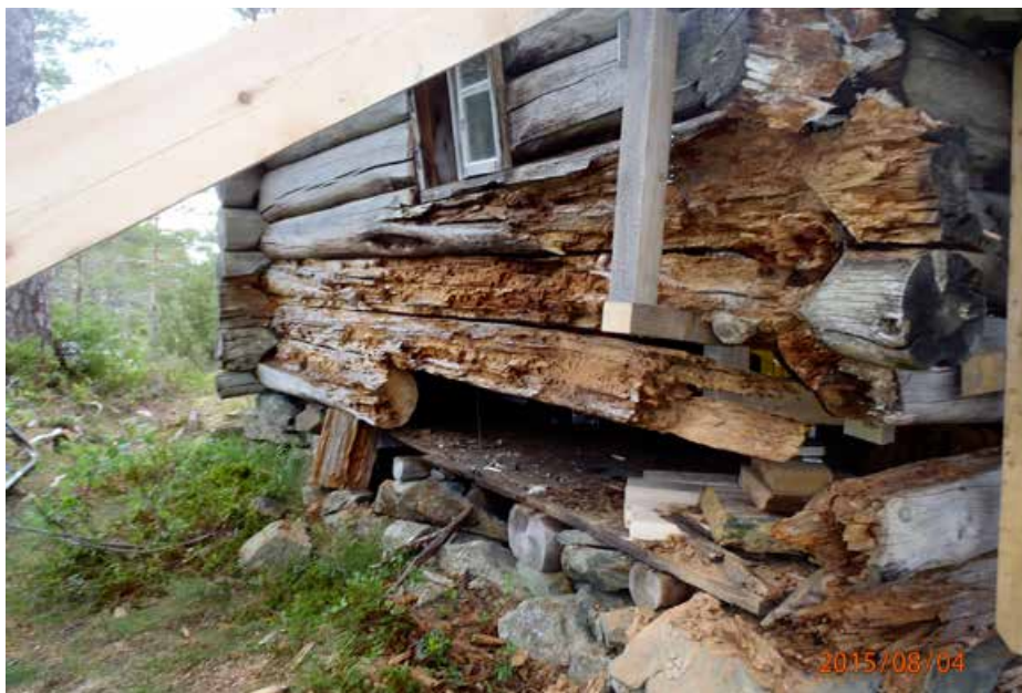
Botnahytta i Samnanger ble restaurert på et laftekurs. 8-10 mann var med på det omfattende arbeidet som ble ledet av Trond Oalann ved Hordaland Fylkeskommune.
