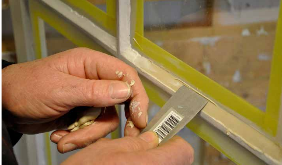
Linoljekitt satt inn med et stoff som kjøttmeisen ikke liker.
