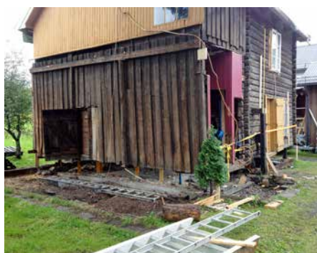
Huset ble jekket opp 70 cm og veggene rettet ut.
