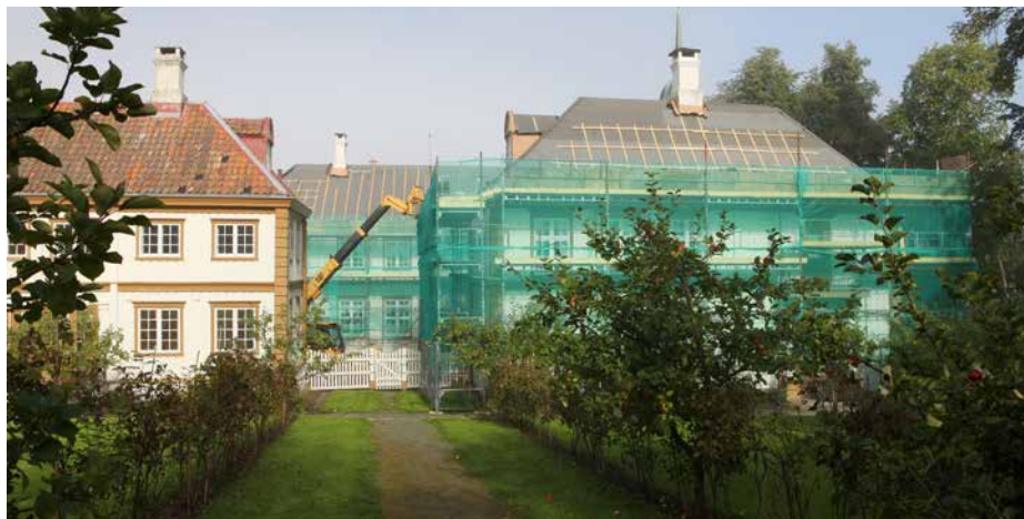
Tømmerne til Braa og Sørvåg Bygg as skiftet sist høst taket på hovedbygningen.
