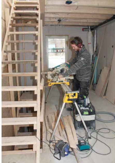
– Det er trangt å arbeide her, men det går helt fint, sier Torjan Knutsen, tømmer i Vågen Byggteknikk AS. Brannvinduet leder inn lys til den bakre delen av tredje etasje.
