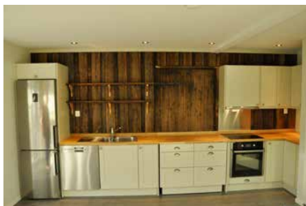
I tilbygget mot gamle del ble de opprinnelige kledningsbordene og dør gjenbrukt der de opprinnelig satt. Når benkeseksjonen foran døren (på hjul) trekkes frem, gir døren adgang til teknisk rom.
