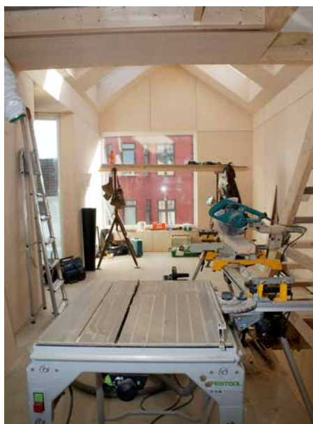
Tømrere, elektrikere og rørleggere må jobbe på skift - så trang er byggeplassen i det smale huset.
