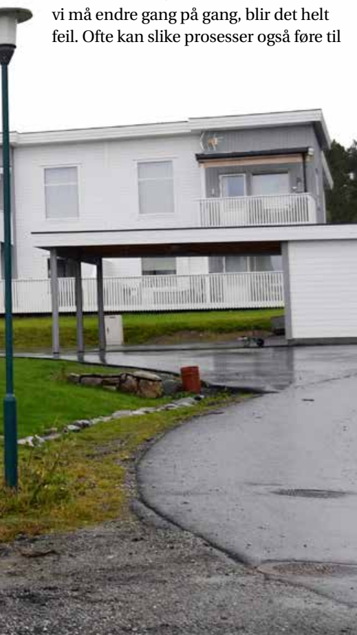
Hustypen bygges også som to- og firemannsbolig.
