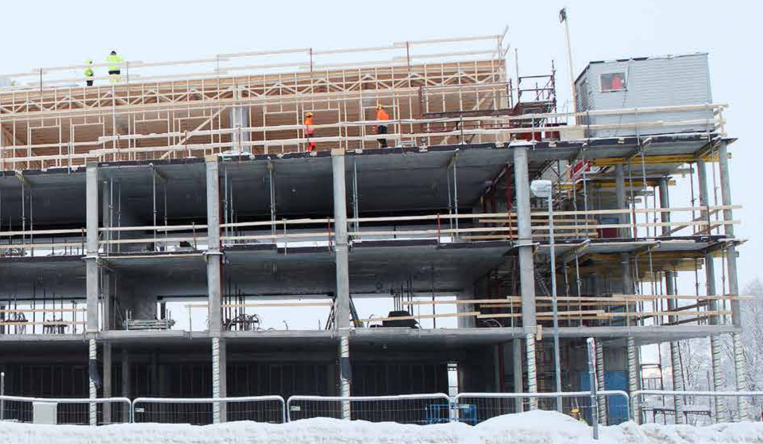
Ramsmoen Terrasse er det største bygget som er satt opp på Tynset på lenge. Det har betongkonstruksjon i tre etasjer, mens den fjerde bygges som et trehus.
