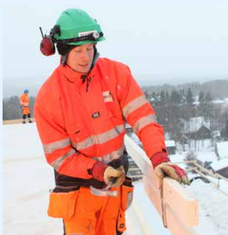
Tømrer Mats Normann setter opp rekkverk på taket.
