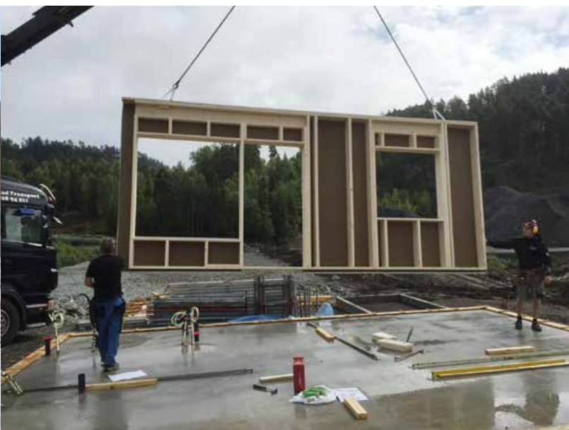
De første elementene ble montert i sommer. Da ble vinduene satt inn på plassen. (Foto: Torger Gurandsrud)
