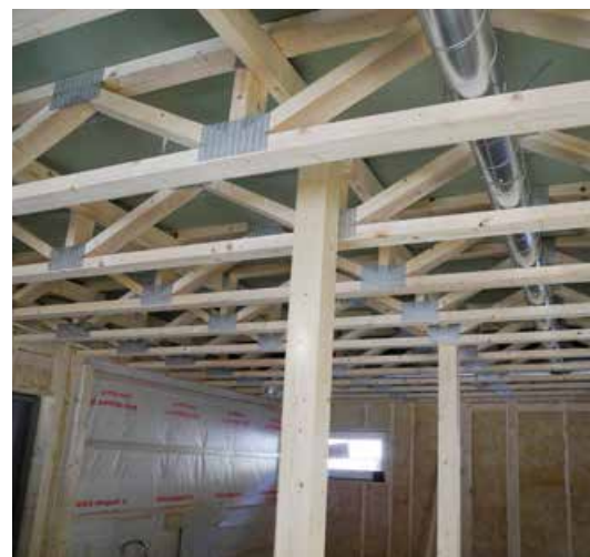
Bjelkelag av gitterdragere har bæring i ytterveggene, og mellomrommet kan brukes til kanaler og føringer. De to stolpene understøtter takkonstruksjonen.
