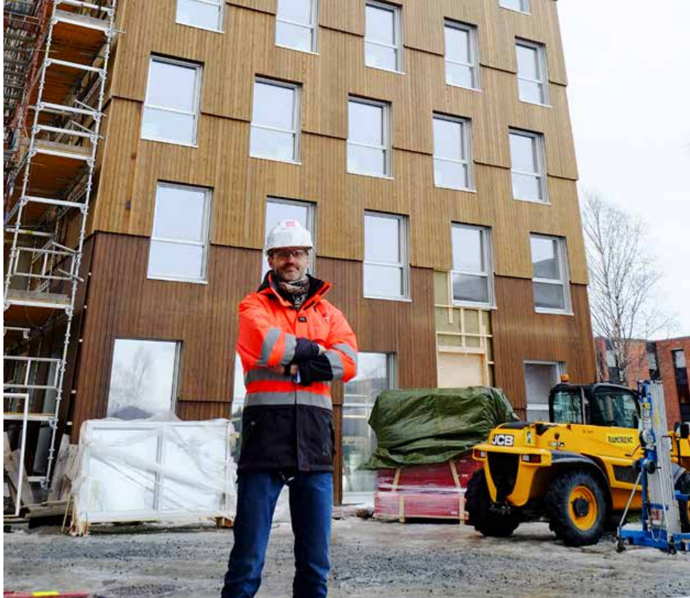
Kebonykledningen på nederste del av hvert tårn er brannimpregnert etter krav fra brannvesenet, forteller prosjekteringsleder Sigbjørn Faanes.
