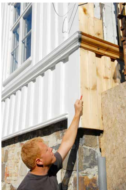
Ny panel og ny profilert list er spunnet inn for å erstatte råttent treverk.
