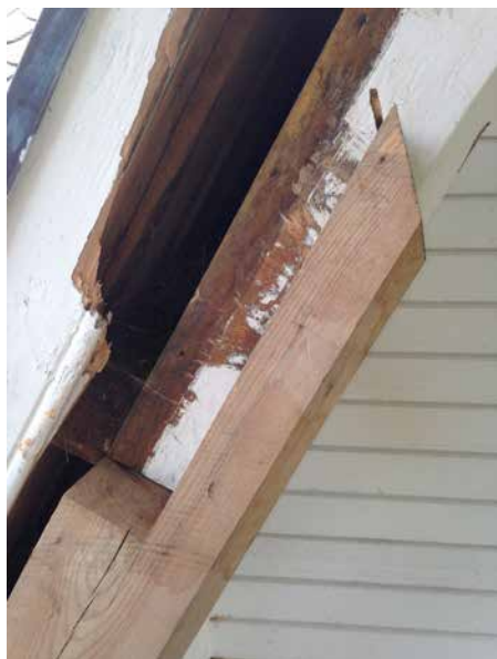
Nytt treverk er tilpasset det gamle. (Foto: Ivar Håndlykken).
