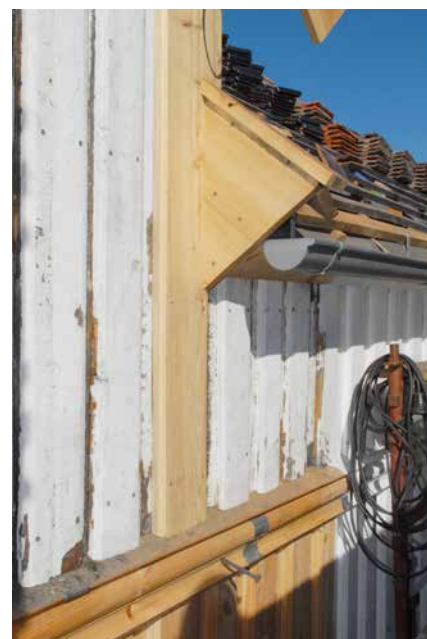
Råttent treverk er fjernet og erstattet med nytt, men mest mulig av det gamle er bevart.
