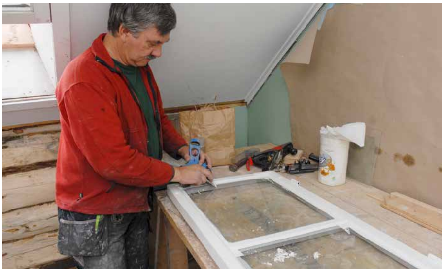
Vinduene er restaurert av Ole Ugland som er ekspert på linoljemaling.
