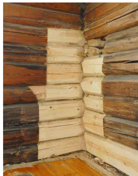
Gammelt treverk måtte erstattes med nytt i flere av de råteherjete lafteknutene.
