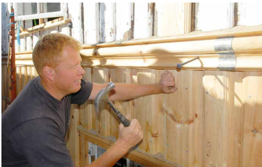
Håndsmidde spiker på omkring 20 cm blir brukt til å feste den profilerte lista som markerer etasjes skillet, demonstrerer tømrer Magnus Liene Gundersen. 50 spiker gikk med. Legg merke til blybeslaget som dekker overgangene mellom lengdene.
