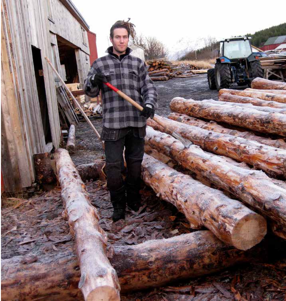
Neil Gouallo forbereder lafting ved å barke stokkene med vanlig barkspeade. (Alle foto: Trygve S. Brenna)
