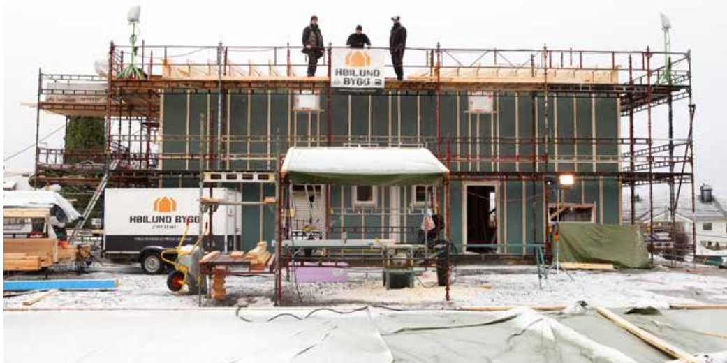
– Hjørnestolpen venter vi med å sette på plass, for å unngå fuktproblemer i isolasjonen, forklarer Stein Ødegaard.
