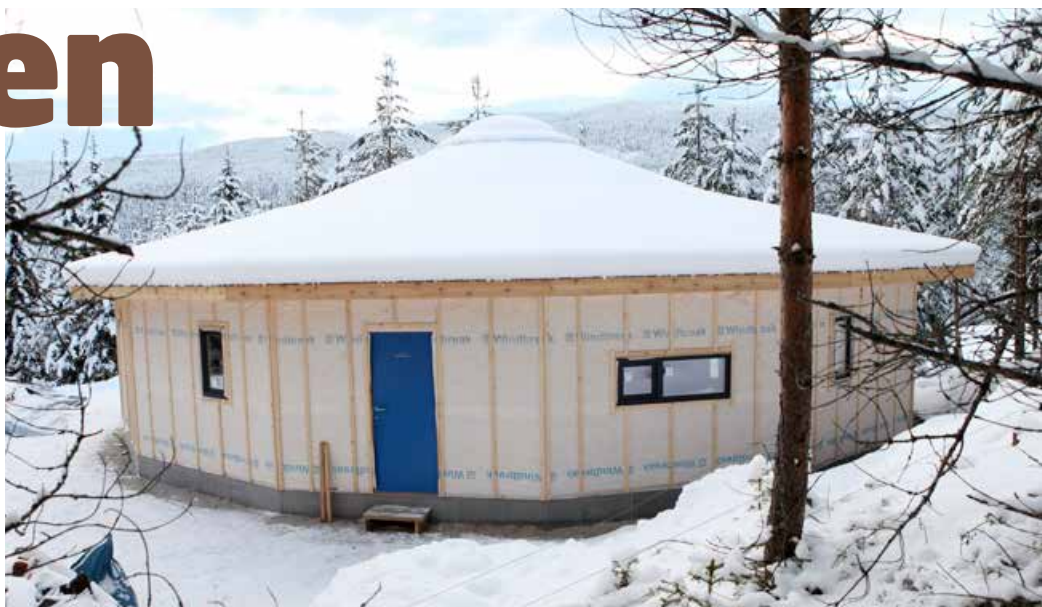
Her er det nye, nesten helt runde huset som er bygget med om lag to meter brede elementer i veggene utvendig.
