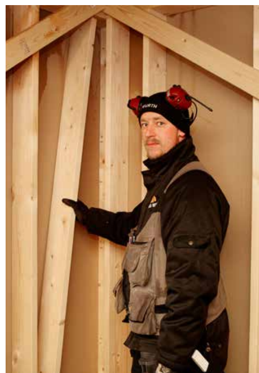
– Hjørnestolpen venter vi med å sette på plass, for å unngå fuktproblemer i isolasjonen, forklarer Stein Ødegaard.
