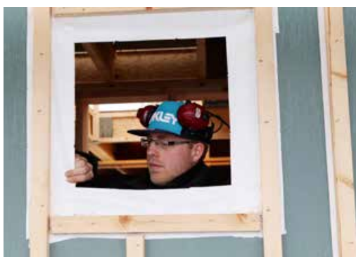
Ole Christian Vollan viser fram Rims vindspærre som er lagt på tidlig for å unngå vann inn i veggen.
