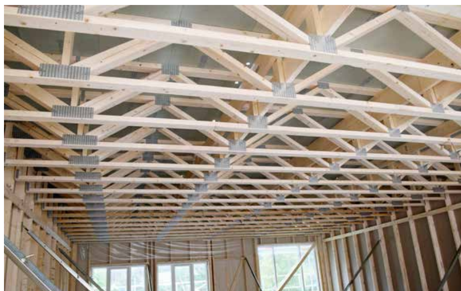
Hulldekker av gitterbjelker og sponplater oppå. En effektiv løsning og god erstatning for betong.
