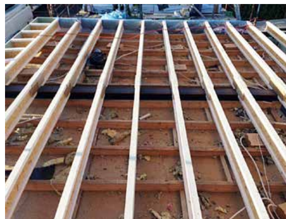
Fra riving og ombygging av saltaket. I-bjelker ble lagt vinkelrett på de gamle undergurtene.
