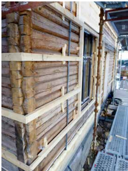
Tømmerveggene måtte rettes opp og føres ut med mellom fem og 10 cm.
