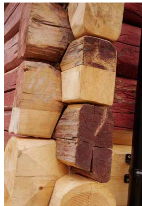
Gammelt blir nytt når hytta settes sammen, og får noen nye løsninger på langsida. Tømmeret har gamle merkinger etter flytting.
