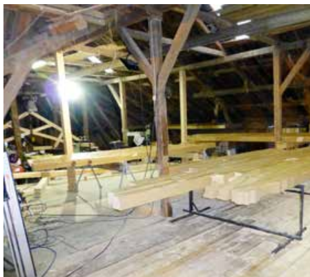
I snekkerverkstedet som er opprettet på låven, ble ulike deler bearbeidet. Her ligger stolpene til verandaen.
