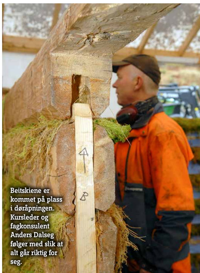
- Dette er en dymbling, en trepinne som brukes for å holde stokkene sammen, demonstrerer Vg2-elev Tor Kristian Knudsen.
