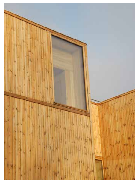
Utenfra synes konstruksjonen godt slik vinduet er lagt helt ut i hjørnet og opp mot taket.
