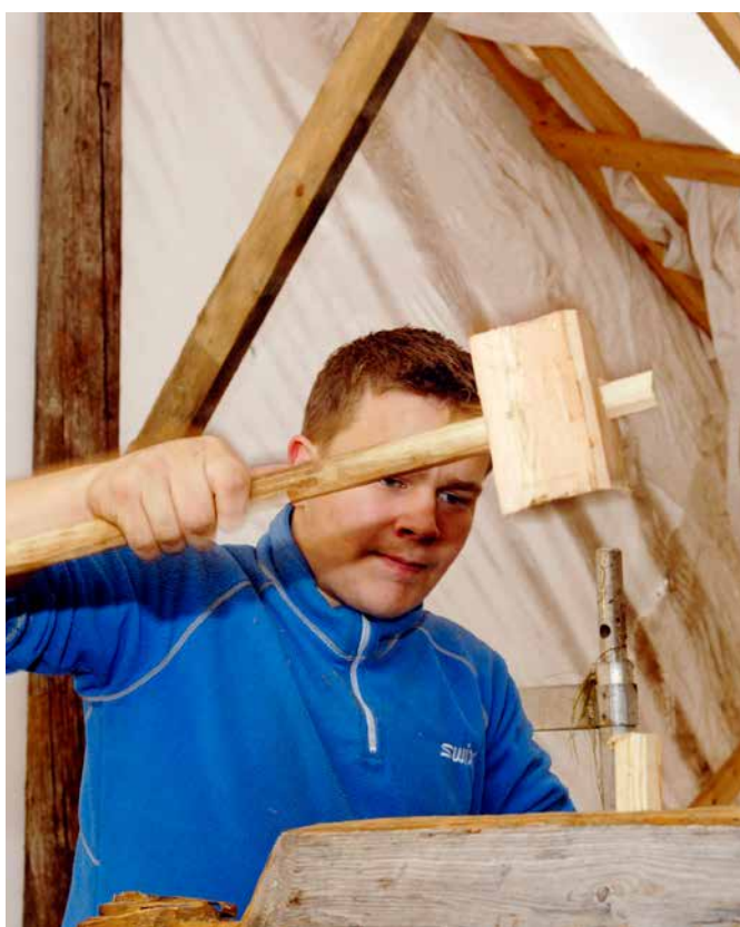
- Dette er en dymbling, en trepinne som brukes for å holde stokkene sammen, demonstrerer Vg2-elev Tor Kristian Knudsen.
